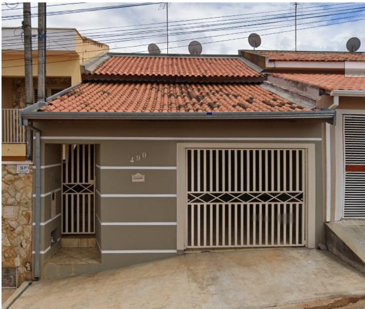
Foto 1: Vista da fachada do imóvel ora avaliando.
