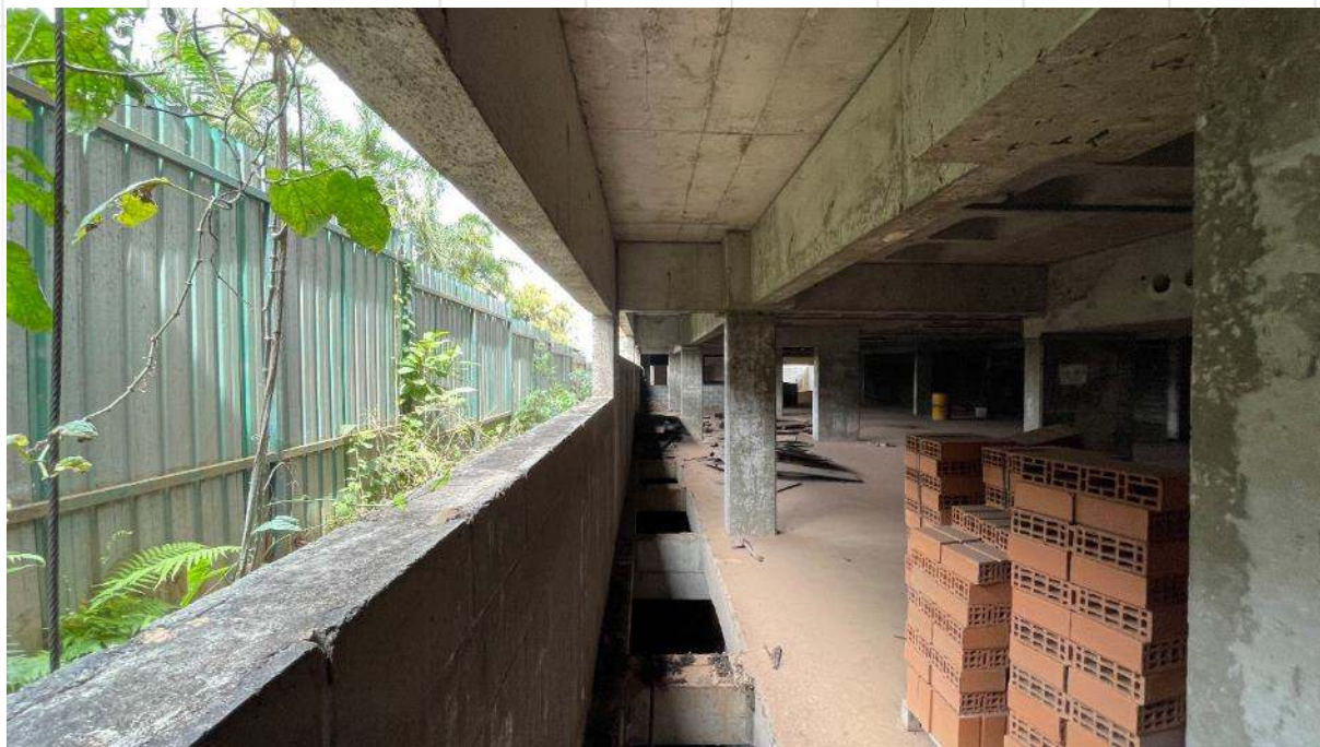
FOTO DE Nº 50. Primeiro subsolo.
