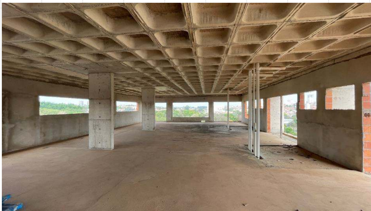
FOTO DE Nº 33. Quarto pavimento.
