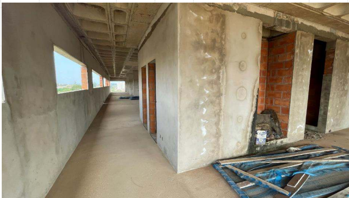
FOTO DE Nº 32. Quarto pavimento.
