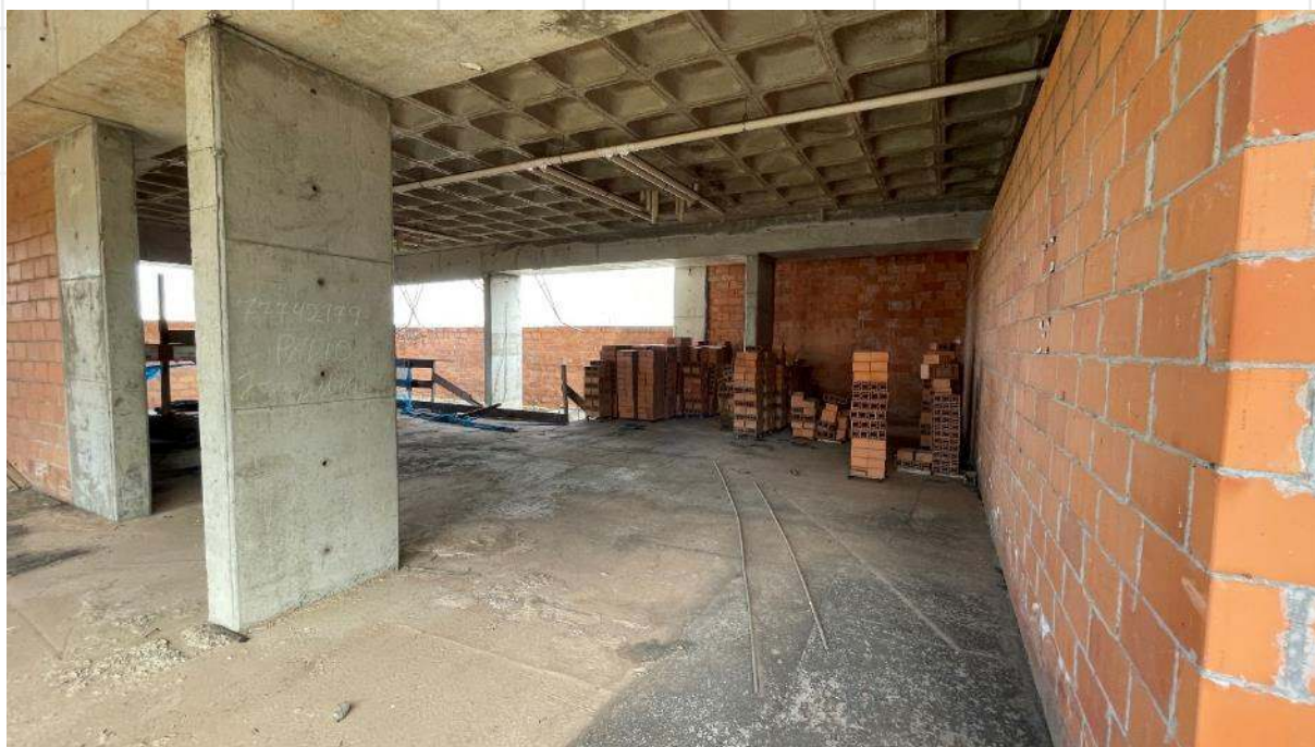
FOTO DE Nº 12. Fundos do pavimento térreo.
