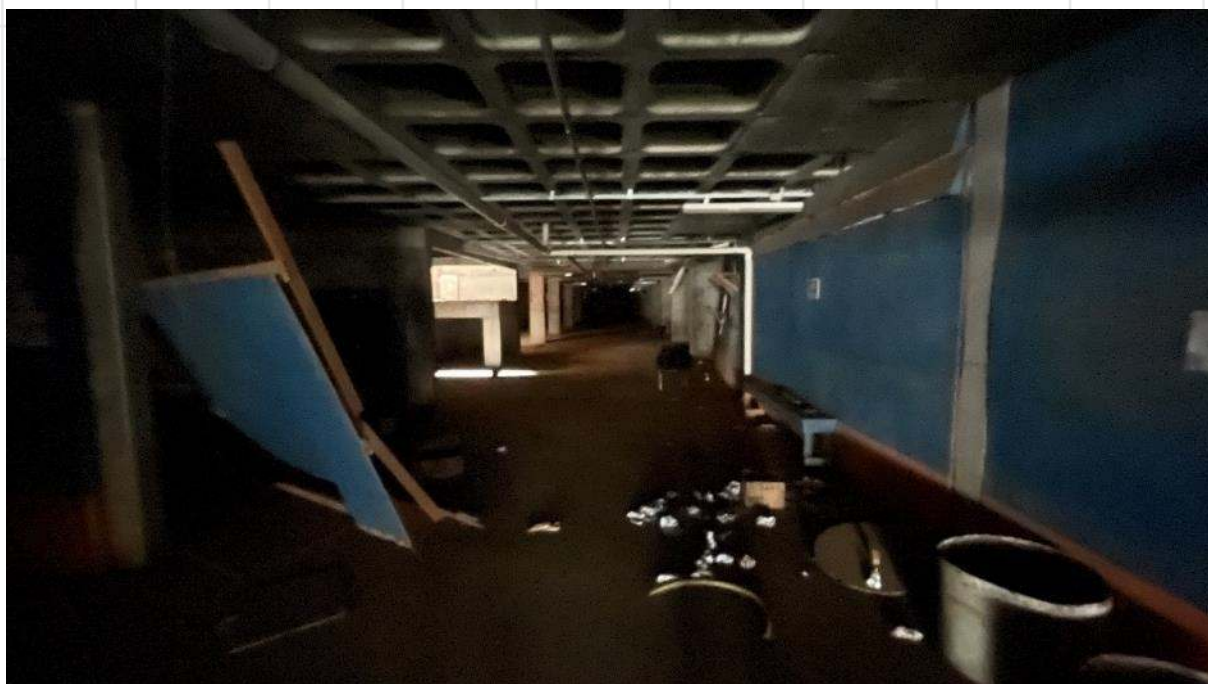
FOTO DE Nº 54. Segundo subsolo.
