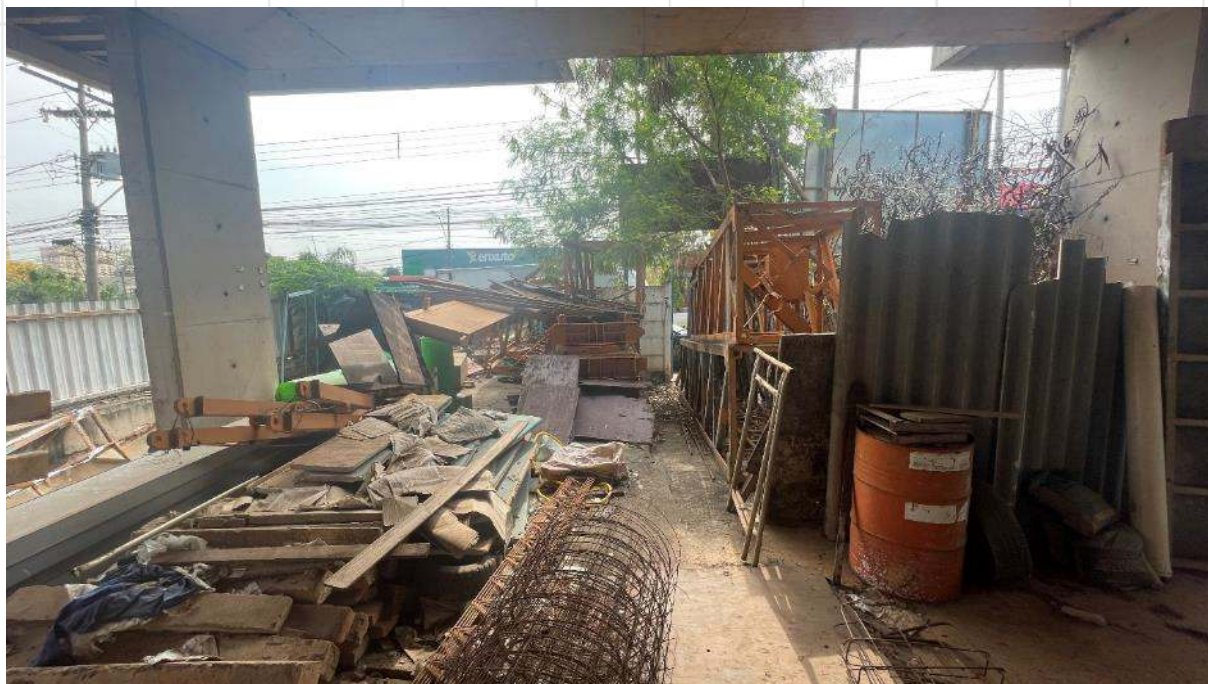
FOTO DE Nº 9. Sala 1 do pavimento térreo.
