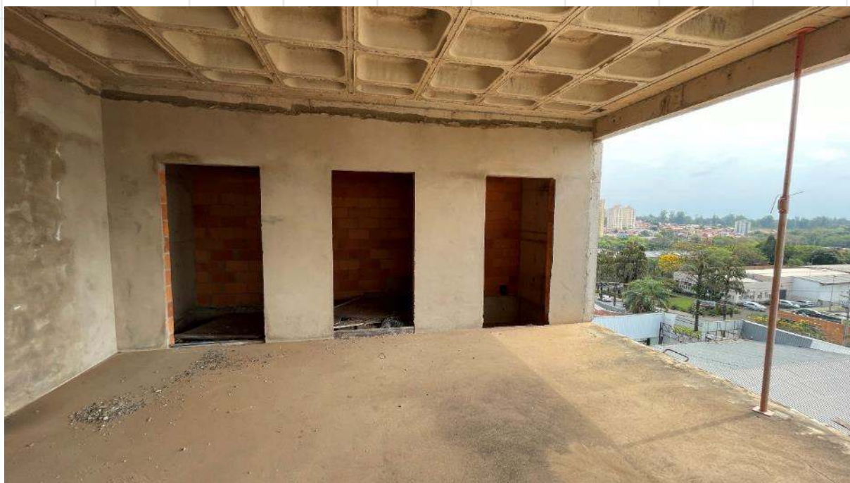
FOTO DE Nº 31. Quarto pavimento.
