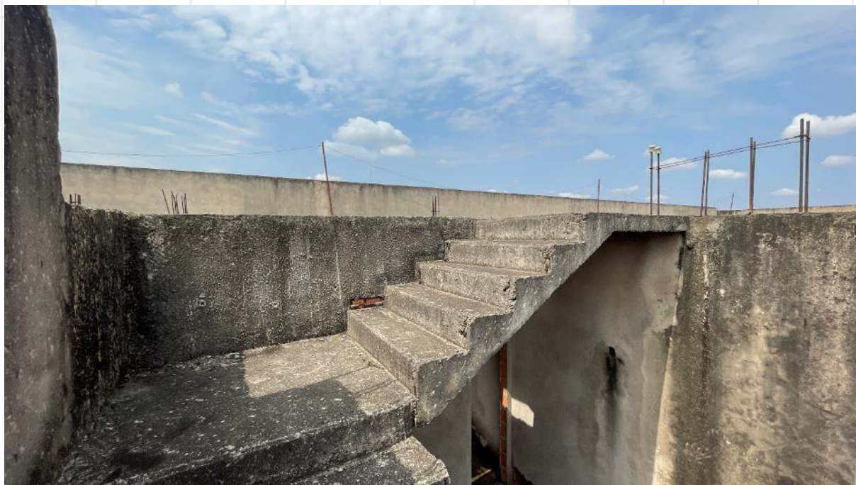
FOTO DE Nº 43. Laje de cobertura do sétimo pavimento.
