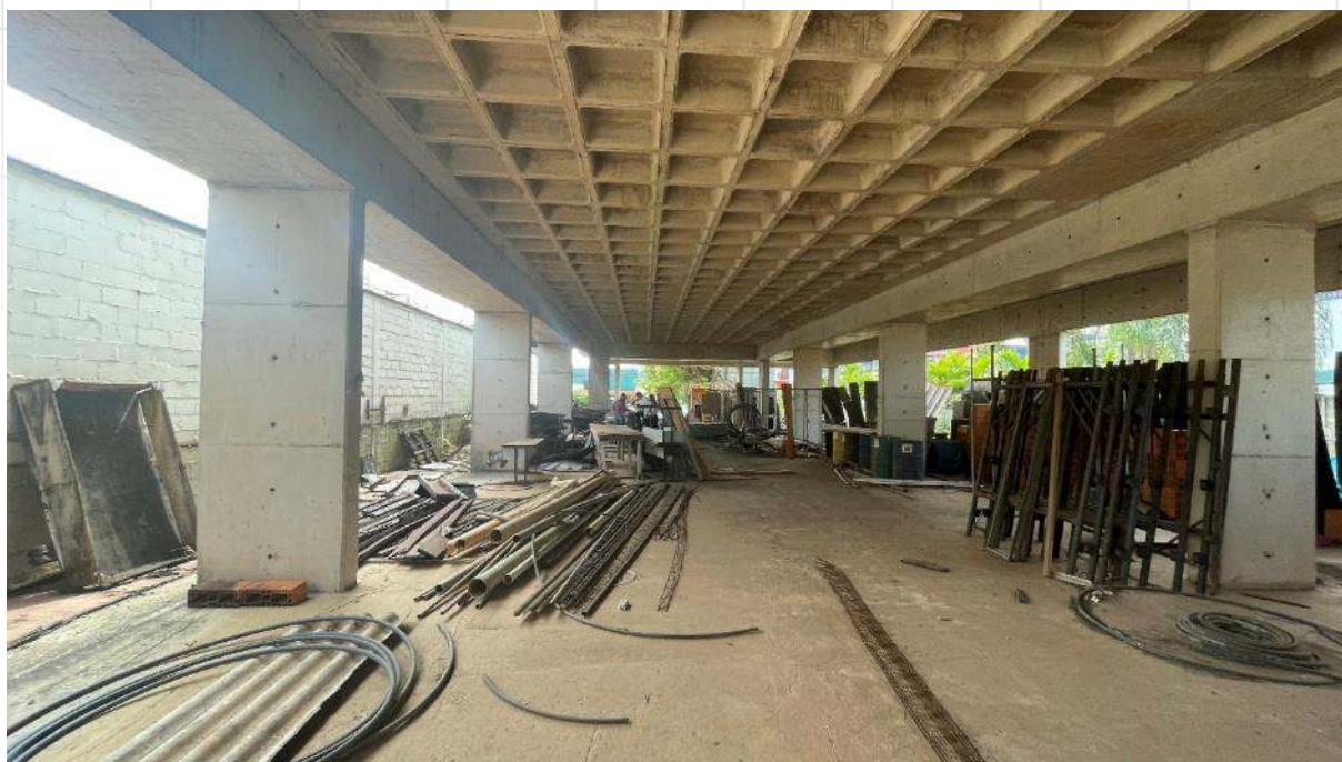
FOTO DE Nº 11. Sala 1 do pavimento térreo.
