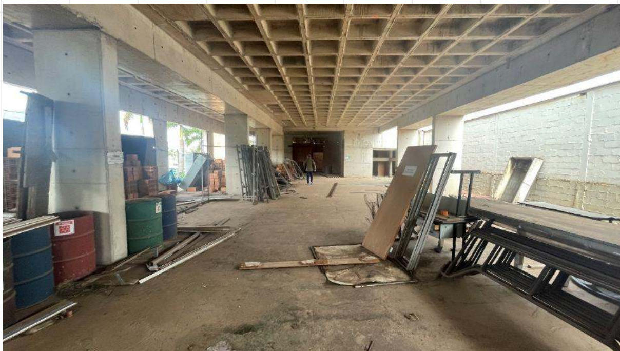
FOTO DE Nº 10. Sala 1 do pavimento térreo.
