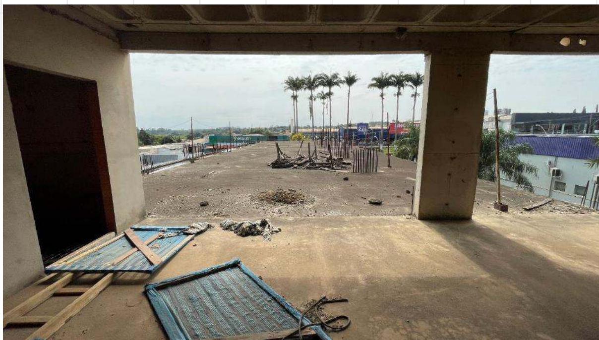
FOTO DE Nº 25. Segundo pavimento.
