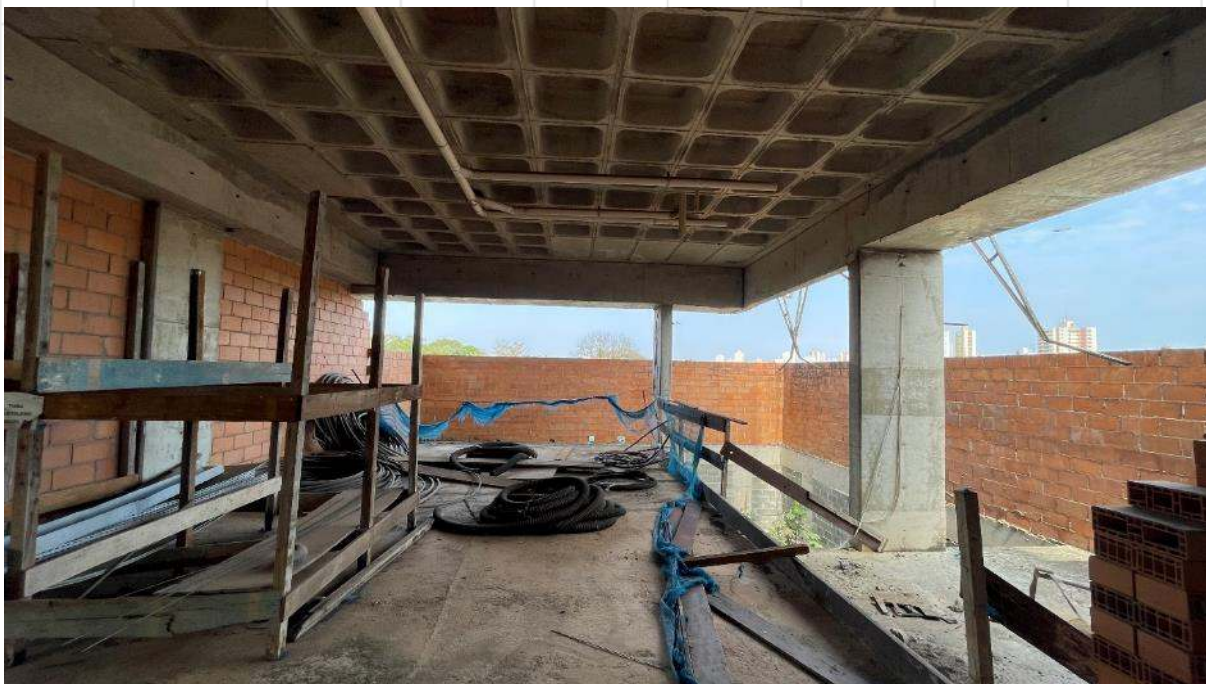
FOTO DE Nº 14. Fundos do pavimento térreo.
