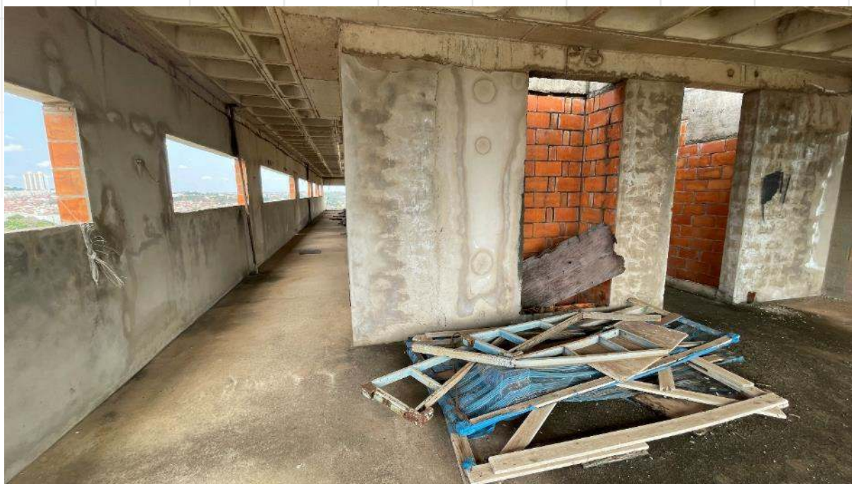
FOTO DE Nº 41. Sétimo pavimento.
