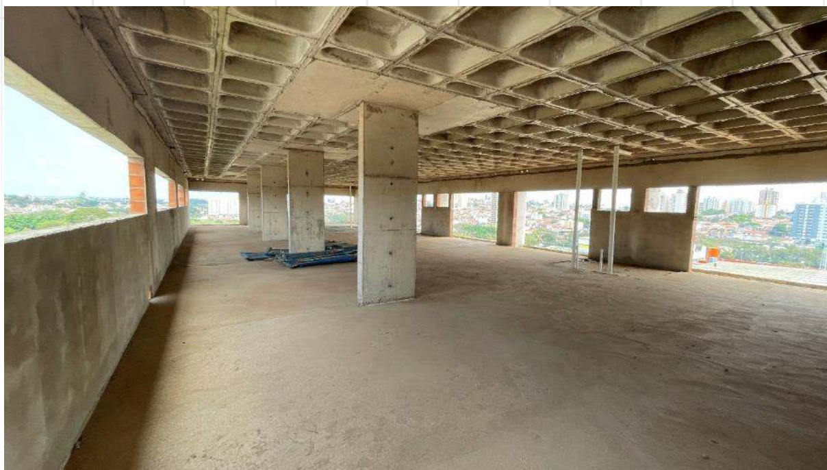
FOTO DE Nº 36. Quinto pavimento.
