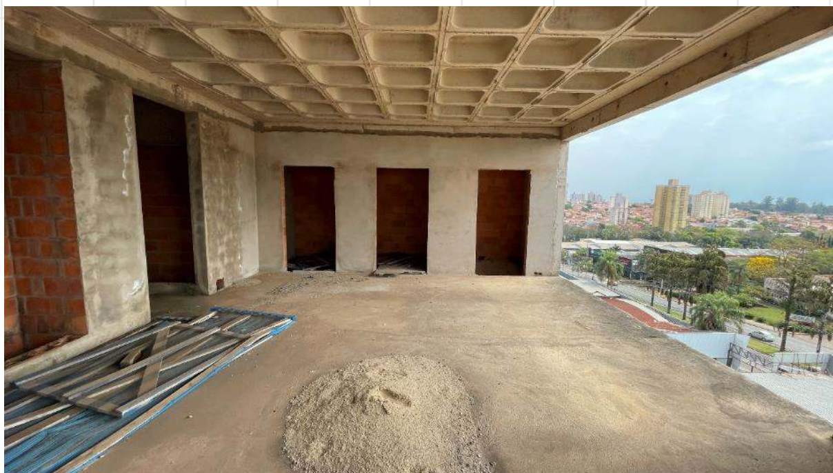
FOTO DE Nº 34. Quinto pavimento.
