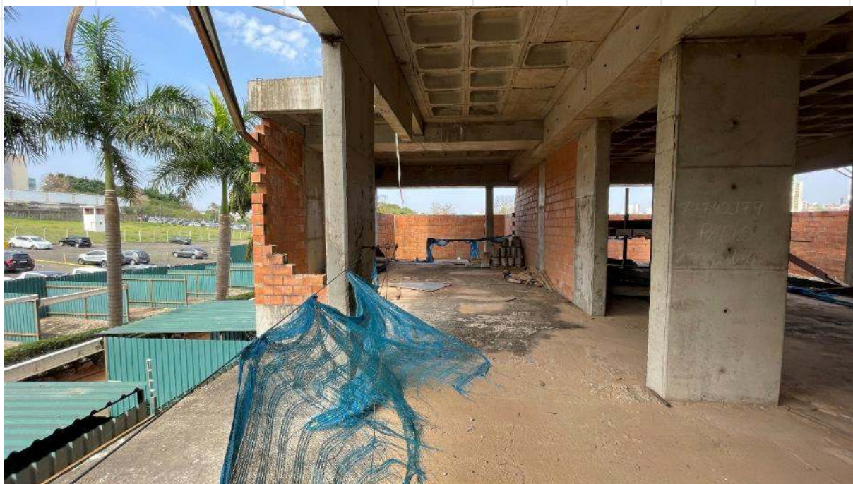
FOTO DE Nº 13. Fundos do pavimento térreo.
