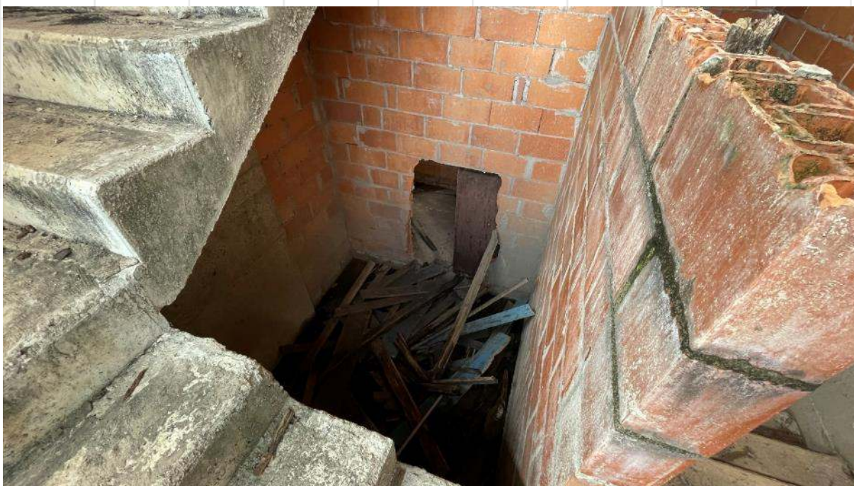
FOTO DE Nº 17. Escadaria do pavimento térreo.
