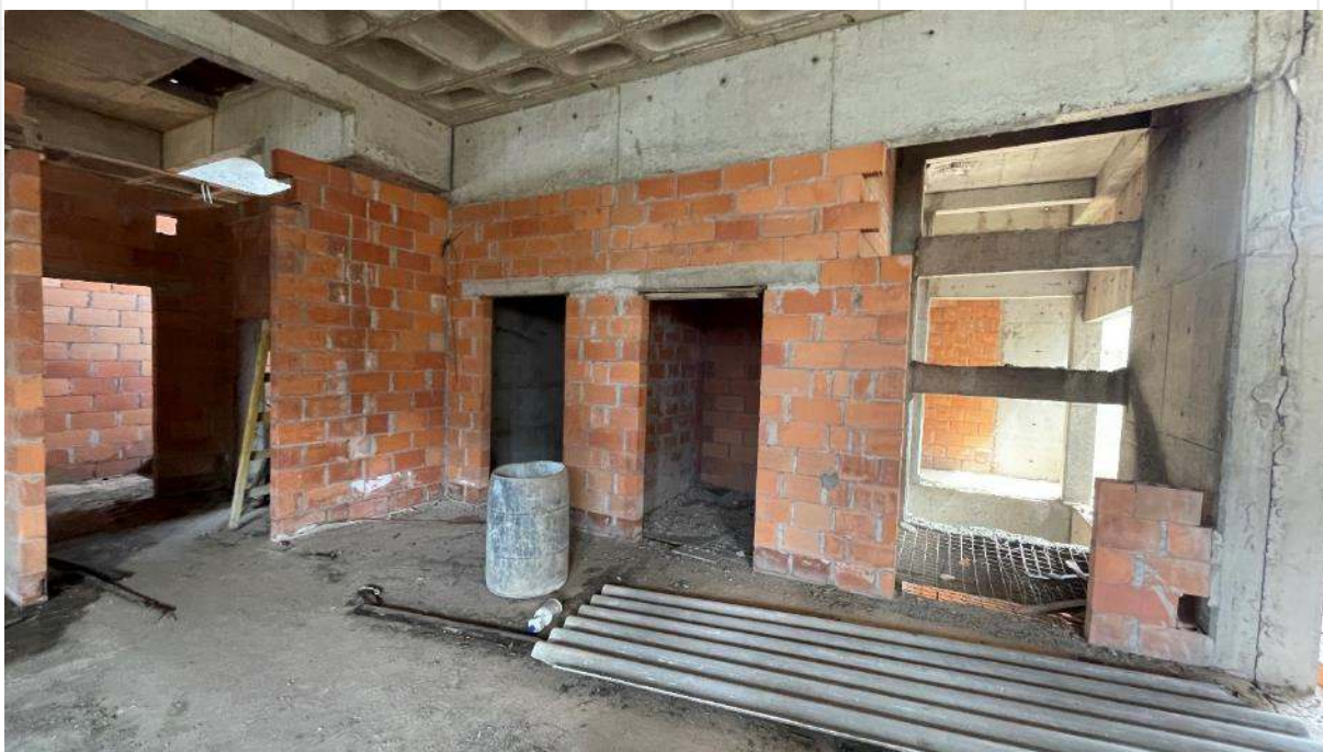
FOTO DE Nº 16. Hall de elevadores do pavimento térreo.
