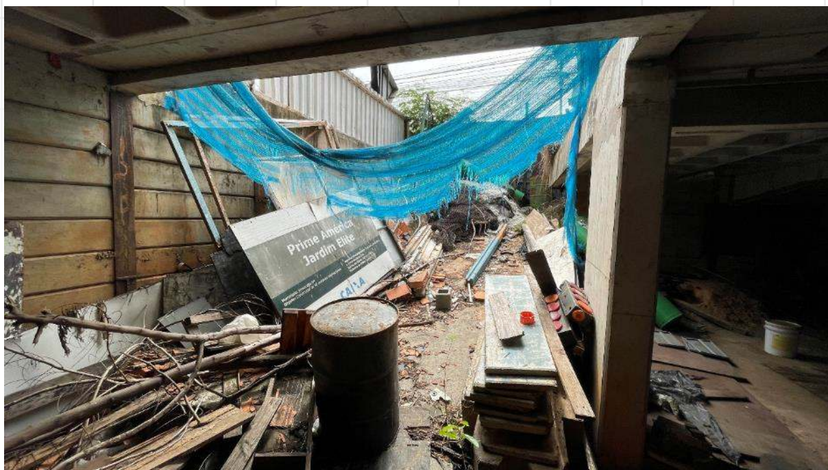
FOTO DE Nº 48. Primeiro subsolo.
