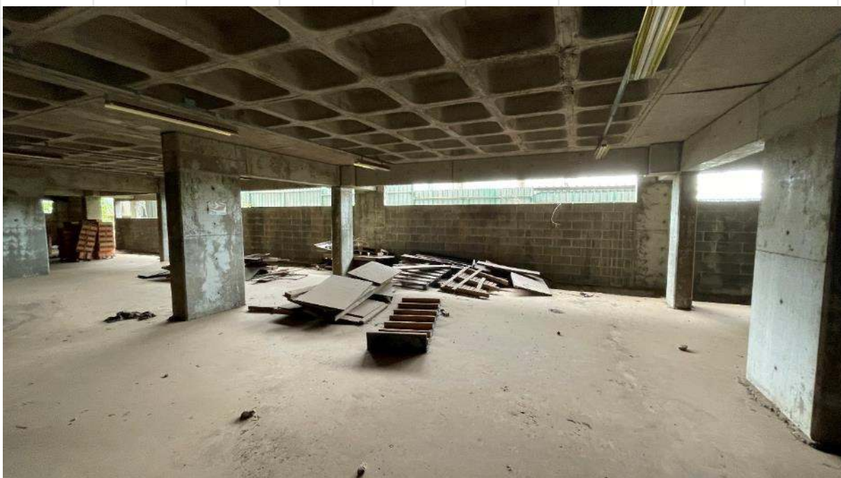
FOTO DE Nº 51. Primeiro subsolo.
