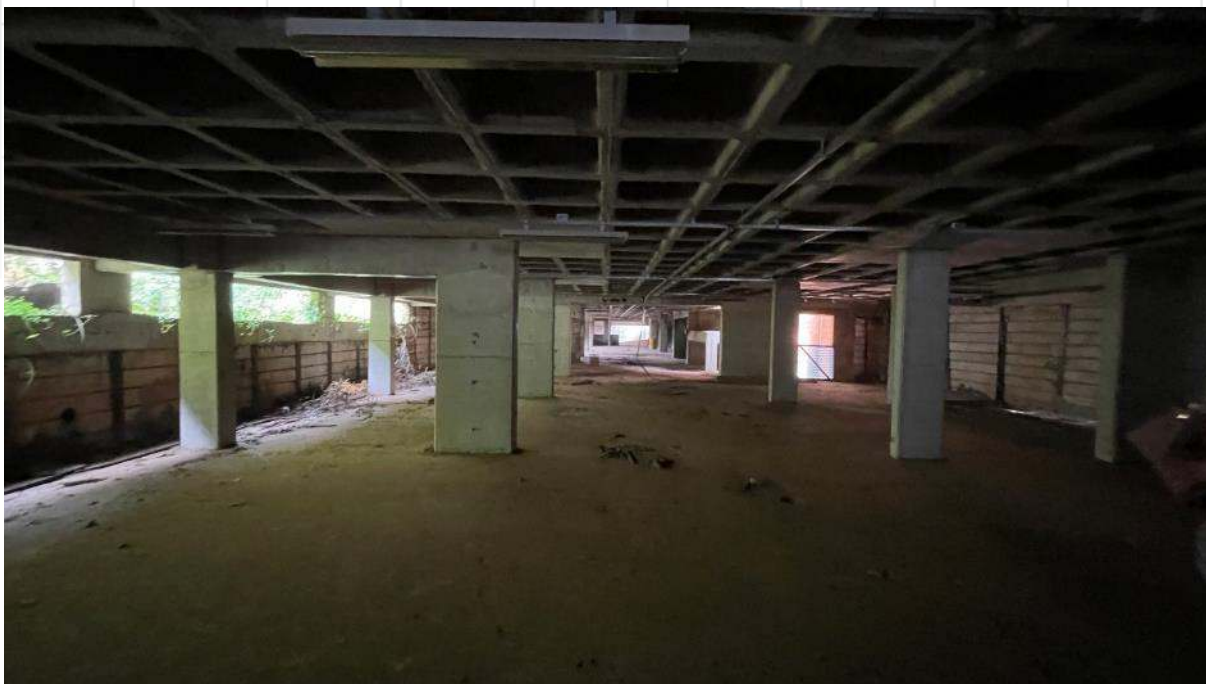
FOTO DE Nº 49. Primeiro subsolo.
