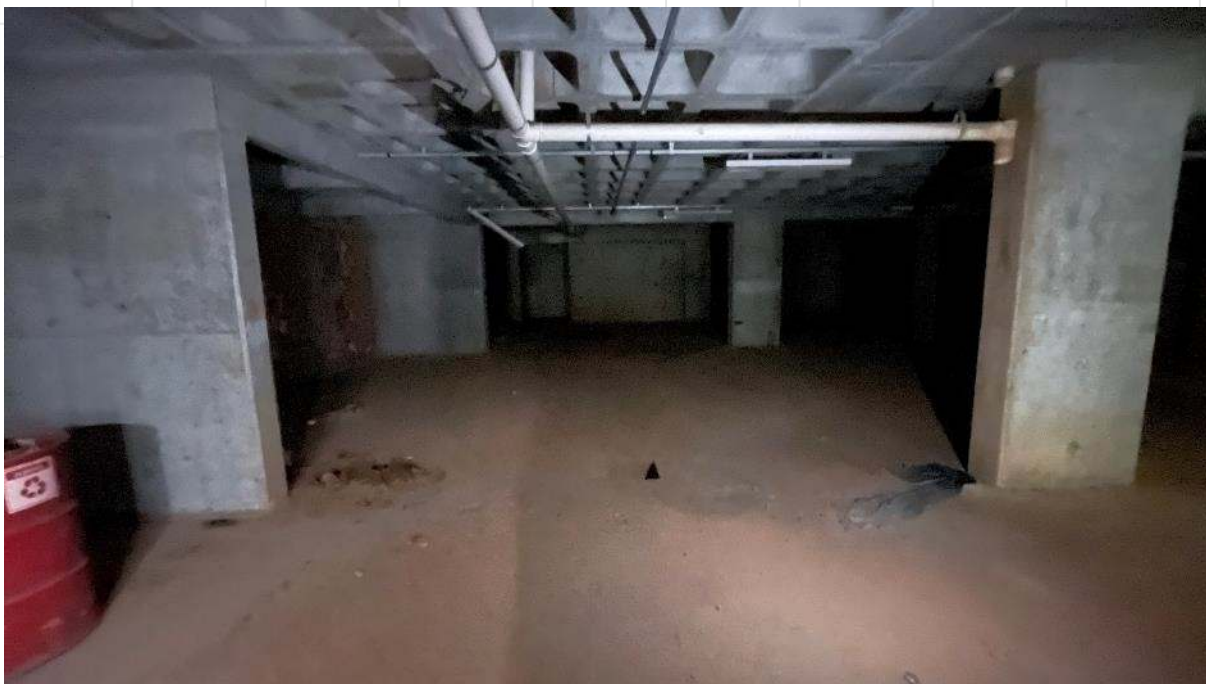
FOTO DE Nº 58. Terceiro subsolo.
