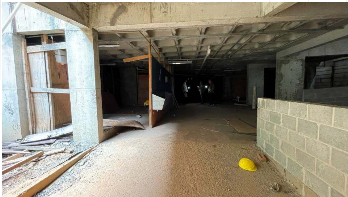
FOTO DE Nº 53. Segundo subsolo.
