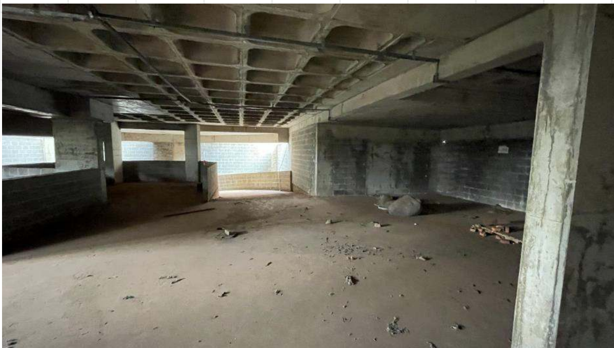
FOTO DE Nº 52. Primeiro subsolo.
