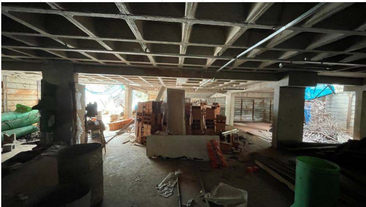
FOTO DE Nº 47. Primeiro subsolo.
