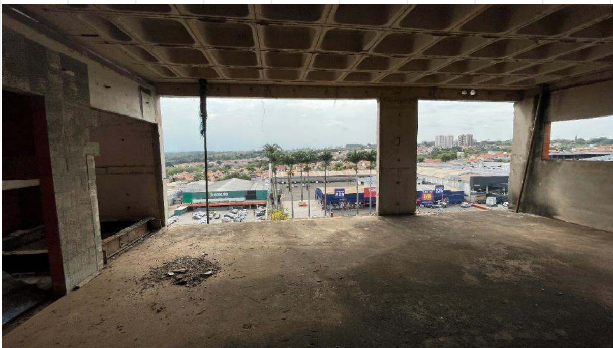
FOTO DE Nº 40. Sétimo pavimento.
