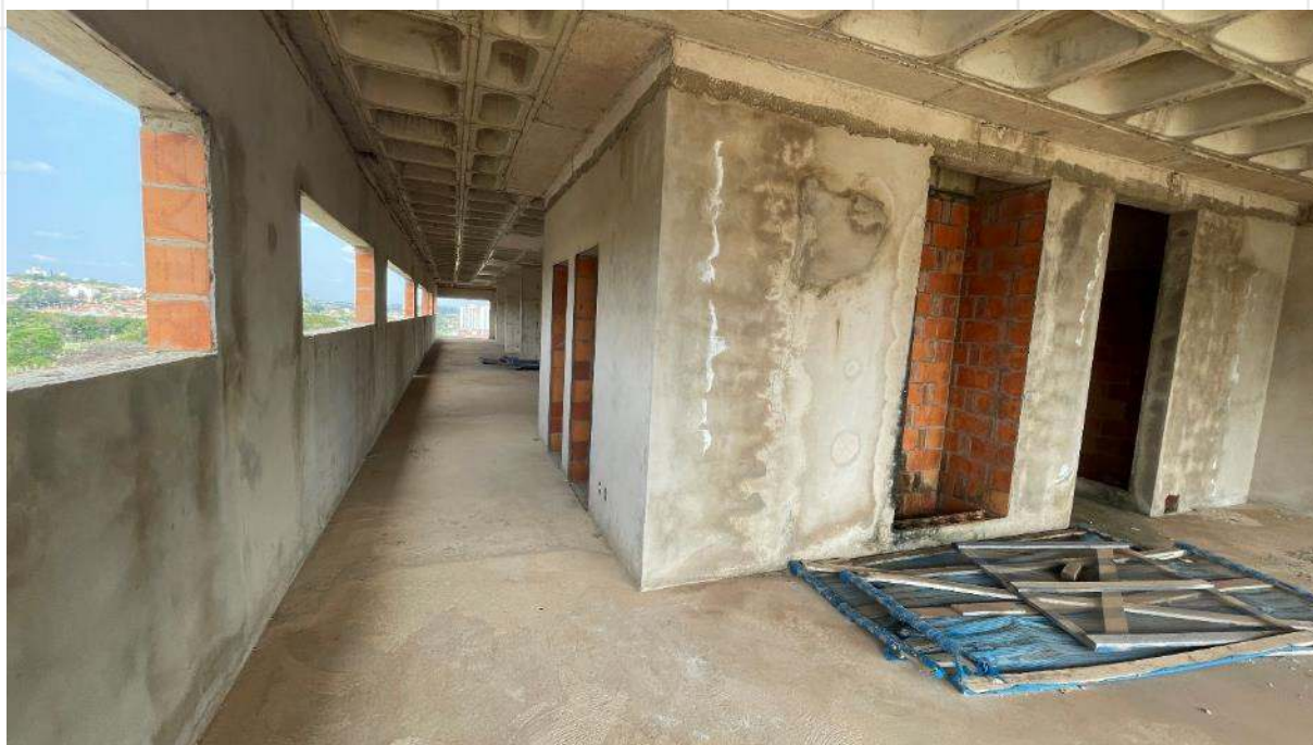
FOTO DE Nº 35. Quinto pavimento.
