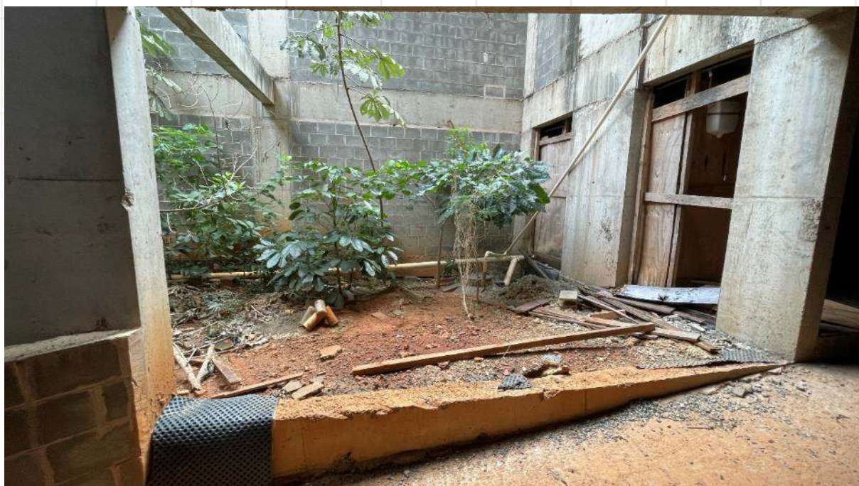
FOTO DE Nº 56. Segundo subsolo.
