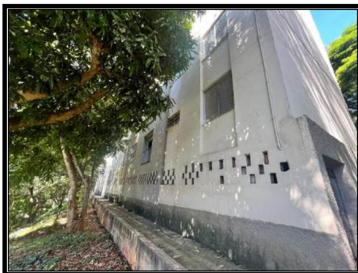
Vista interna do bloco:
