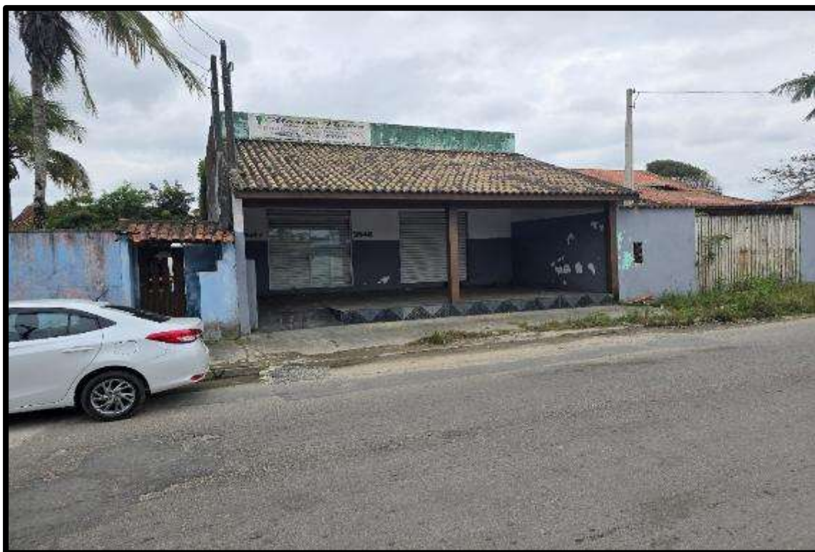
Foto nº 3: Vista da fachada do imóvel avaliando sob nº 3546.
