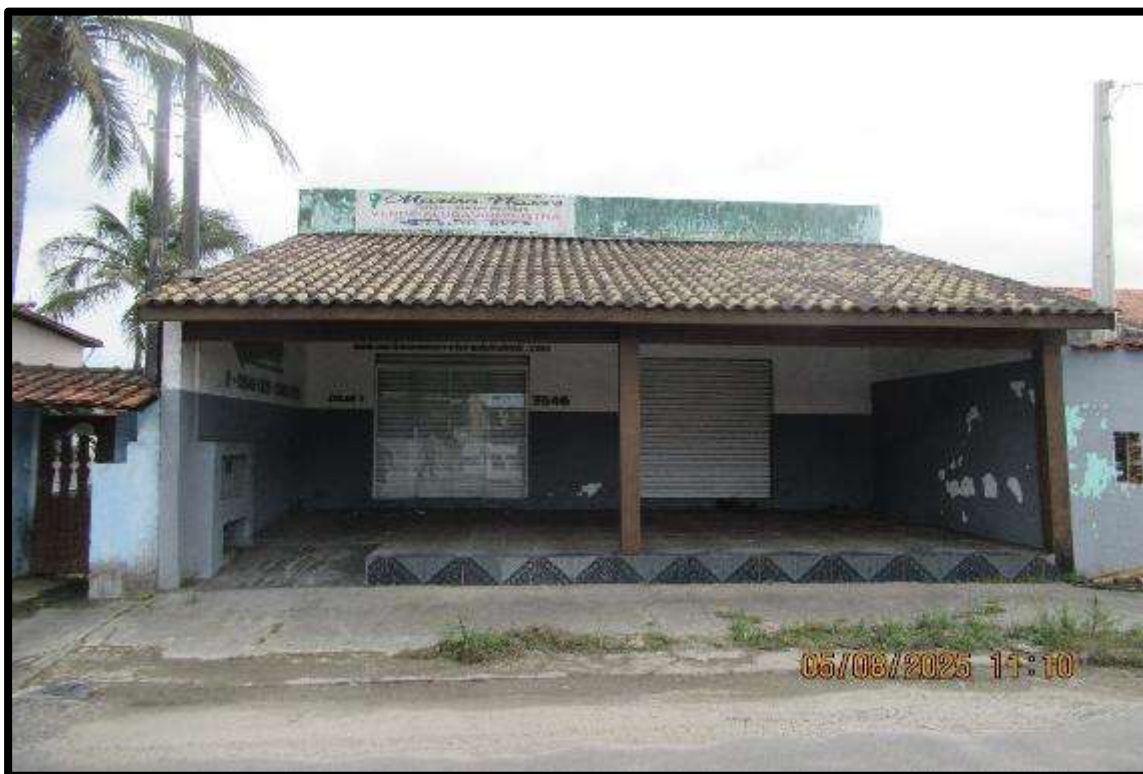
Foto nº 4: Detalhe do imóvel avaliando utilizado para fins comerciais.
