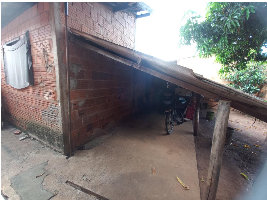
Foto17: Cobertura em telhas de fibrocimento na lavanderia da casa dos fundos
