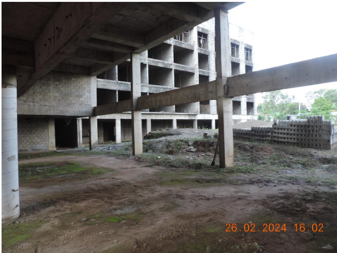
FOTO N° 18 – PAVIMENTO TERREO DA EDIFICAÇÃO, VISTA PARCIAL
