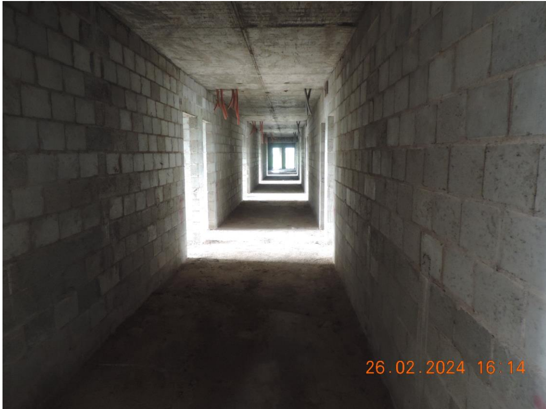
FOTO Nº 35 – 2º PAVIMENTO DA EDIFICAÇÃO, VISTA PARCIAL
