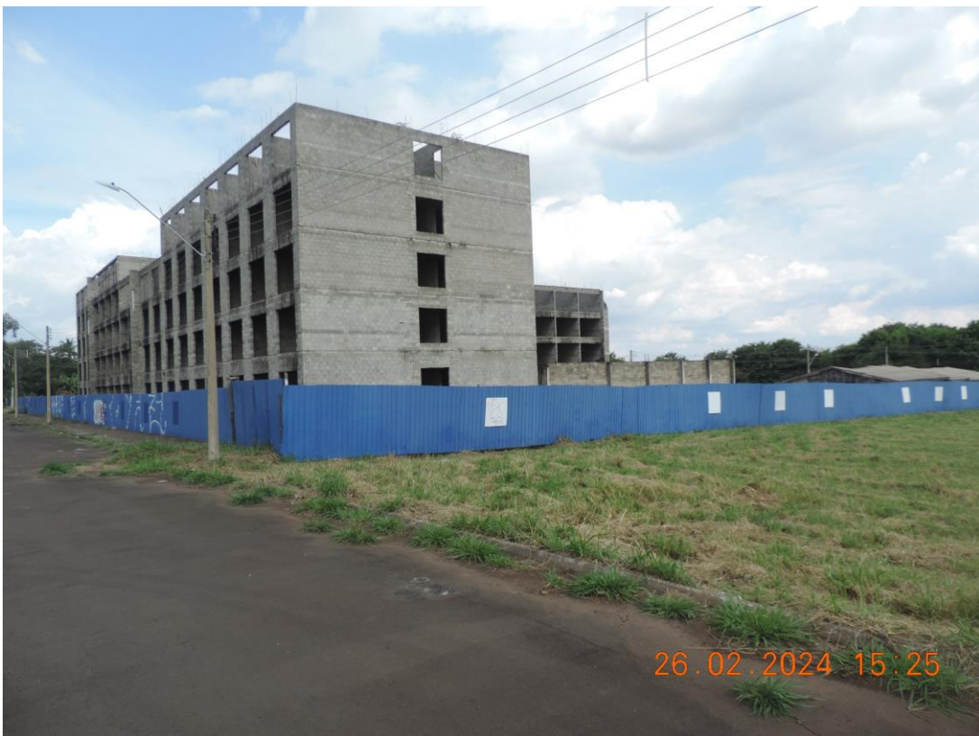
FOTO Nº 02 – VISTA EXTERNA DO IMÓVEL, A PARTIR DA RUA IMP. GIULIANO
