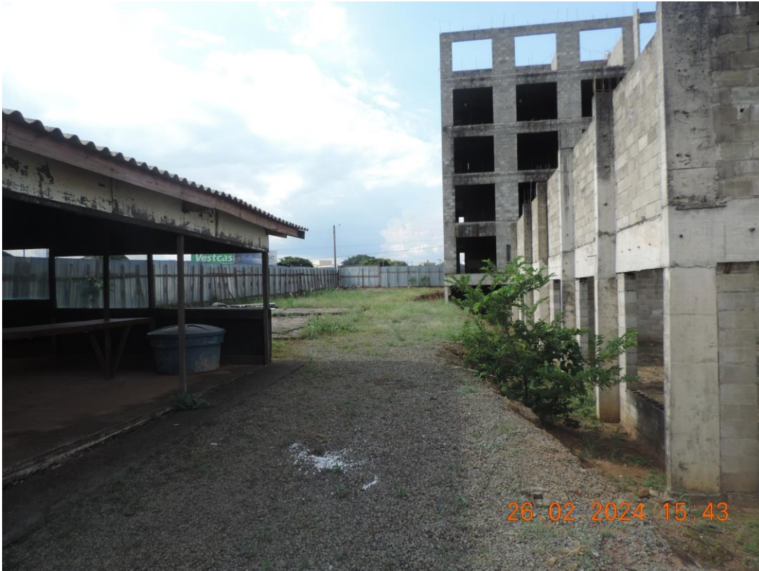
FOTO N° 15 – VISTA INTERNA DO IMÓVEL
