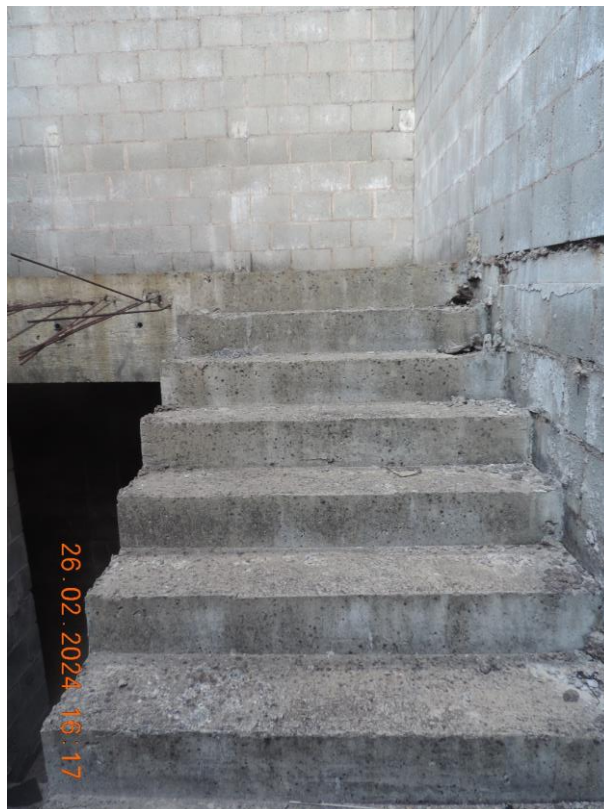
FOTO N° 42 – ESCADA DE ACESSO AO 4° PAVIMENTO
