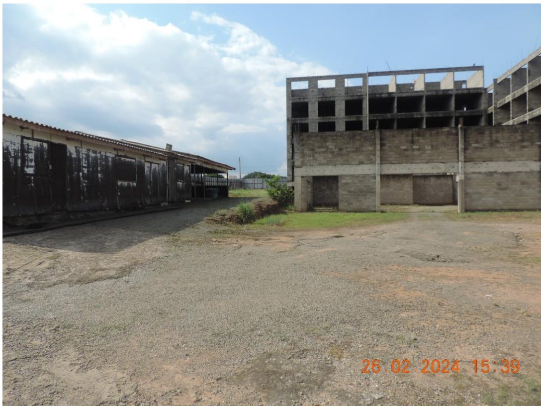
FOTO N° 10 – VISTA INTERNA DO IMÓVEL, POR OUTRO ÂNGULO
