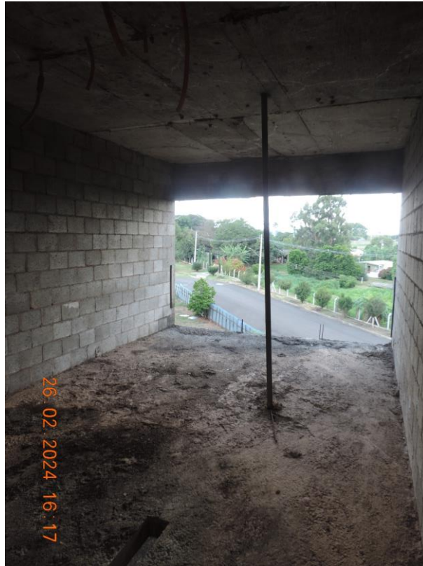
FOTO N° 41 – 3° PAVIMENTO DA EDIFICAÇÃO, VISTA PARCIAL
