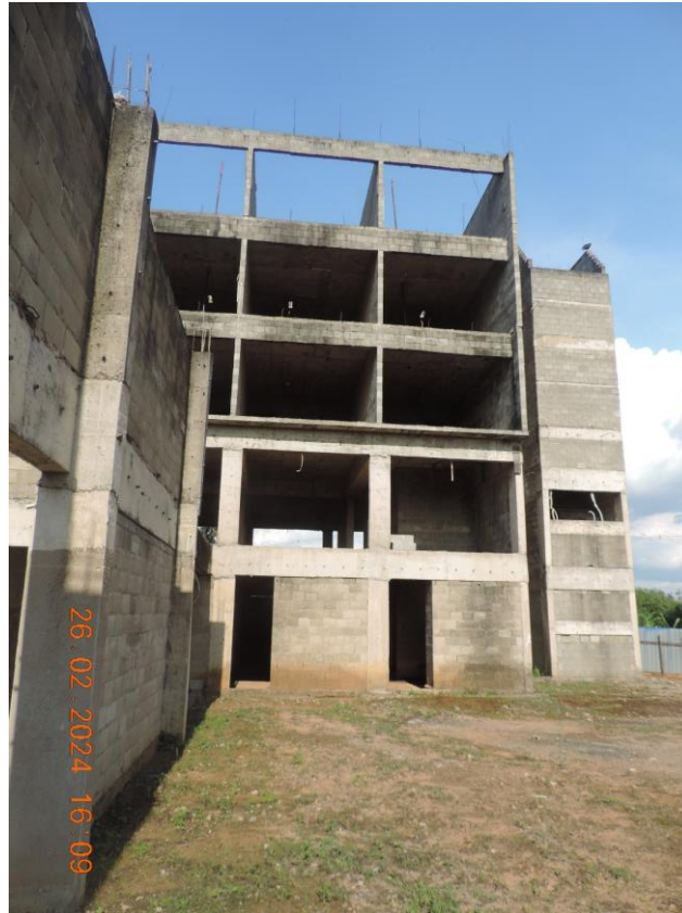
FOTO Nº 25 – PAVIMENTO TERREO DA EDIFICAÇÃO, VISTA PARCIAL
