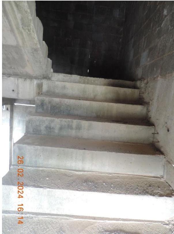
FOTO Nº 33 – ESCADA DE ACESSO AO 2º PAVIMENTO
