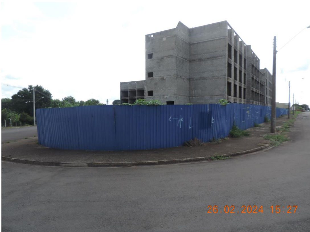
FOTO Nº 04 – VISTA EXTERNA DO IMÓVEL, A PARTIR DA ESQUINA
