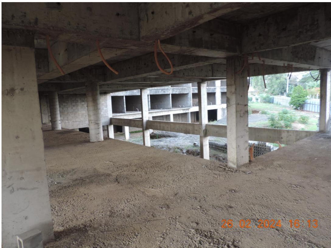
FOTO Nº 32 – 1º PAVIMENTO DA EDIFICAÇÃO, VISTA PARCIAL
