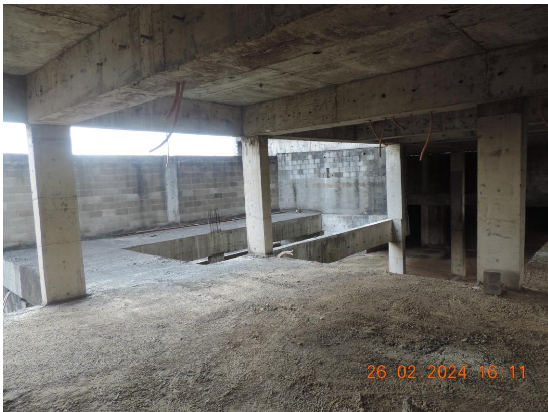
FOTO Nº 28 – 1º PAVIMENTO DA EDIFICAÇÃO, VISTA PARCIAL
