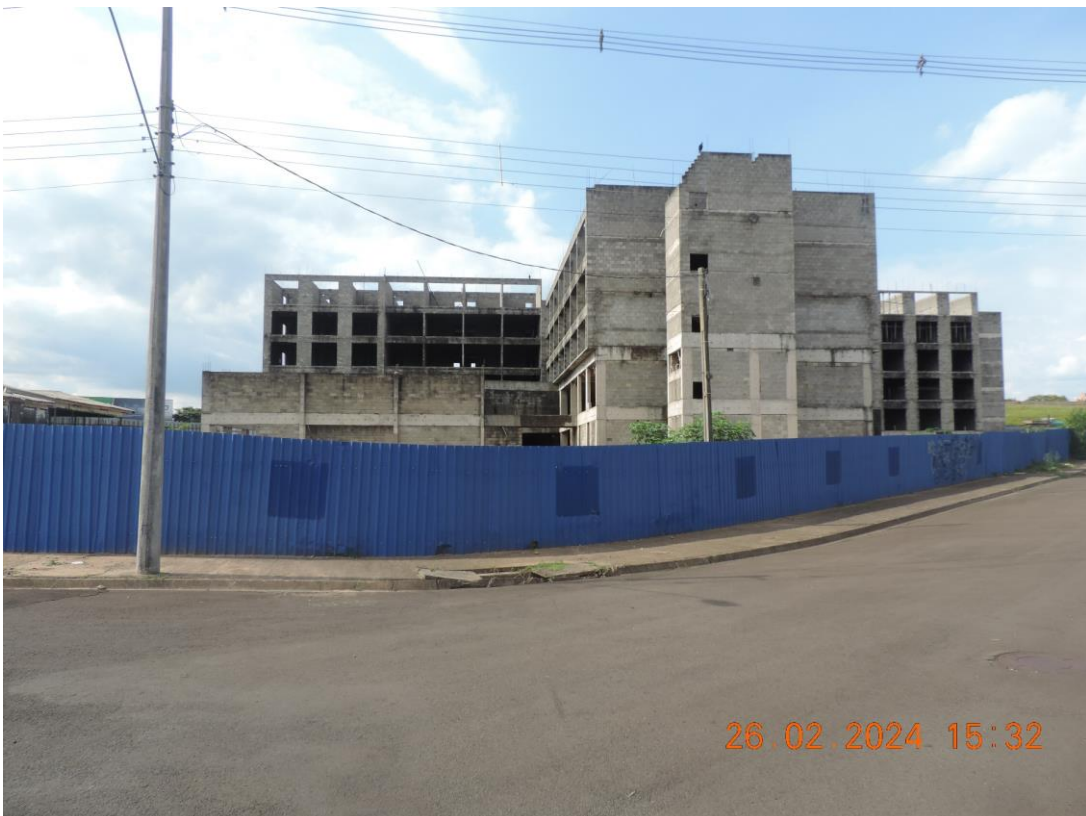
FOTO Nº 06 – VISTA DA ESQUINA R. IMP. M. AURELIO X R. IMP. M. AURELIO
