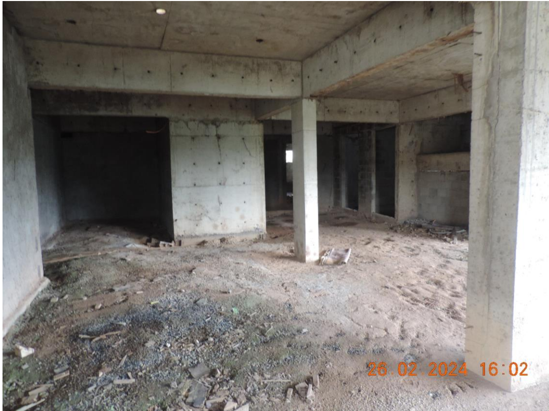
FOTO Nº 19 – PAVIMENTO TERREO DA EDIFICAÇÃO, VISTA PARCIAL
