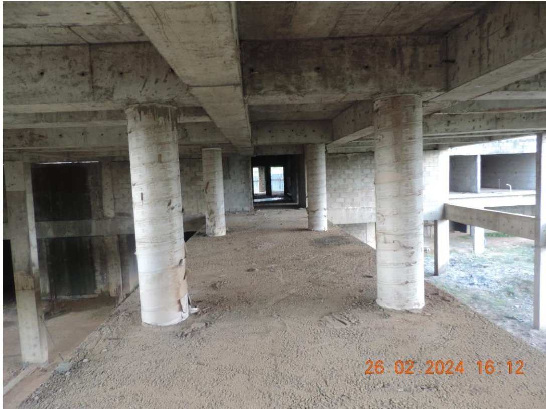
FOTO Nº 29 – 1º PAVIMENTO DA EDIFICAÇÃO, VISTA PARCIAL
