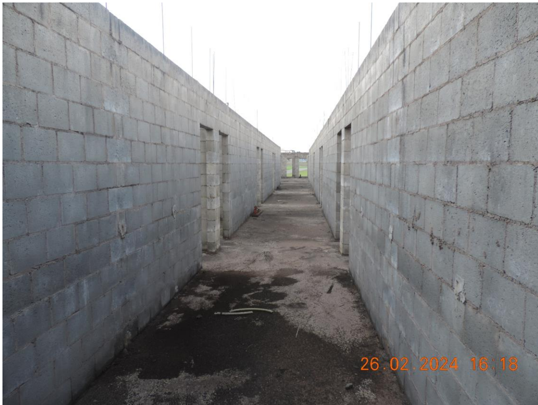
FOTO Nº 43 – 4º PAVIMENTO DA EDIFICAÇÃO, VISTA PARCIAL
