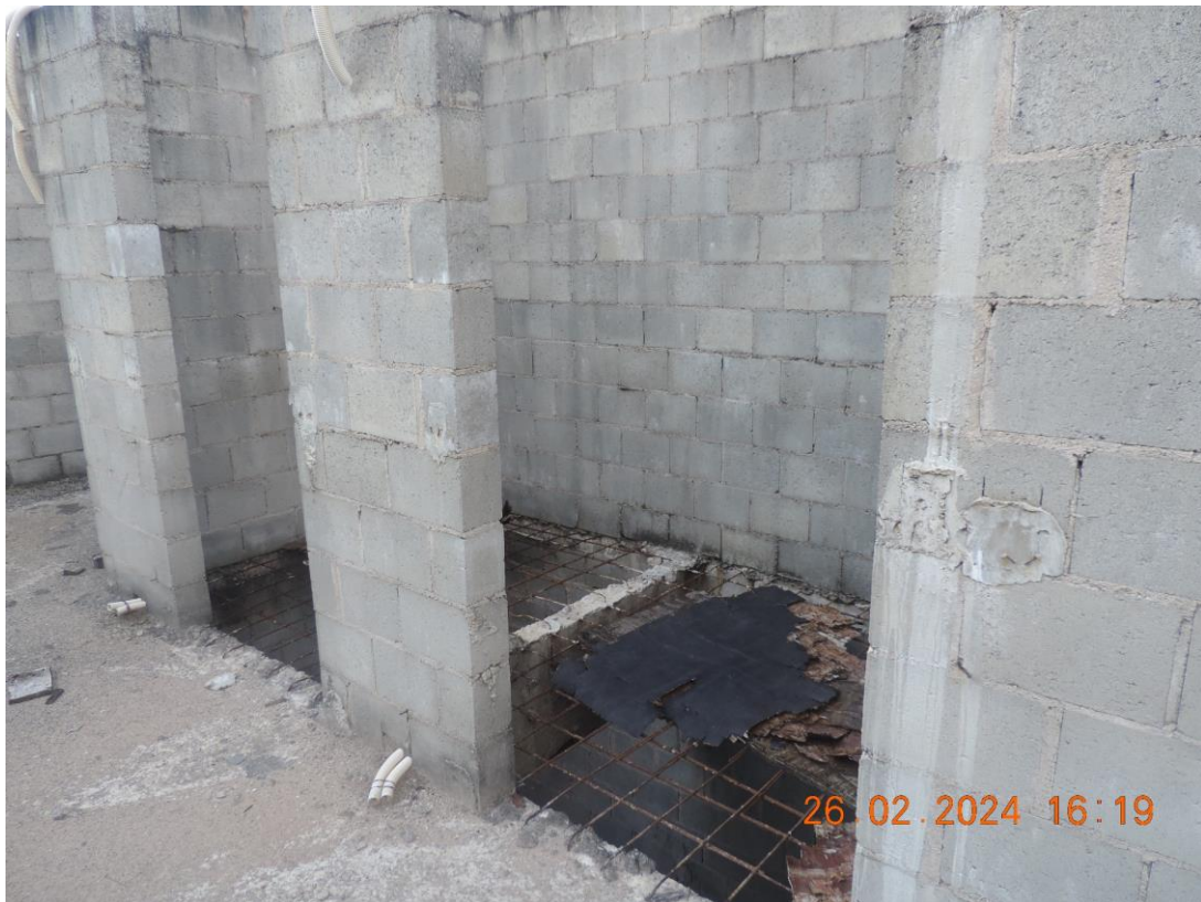
FOTO N° 47 – 4° PAVIMENTO DA EDIFICAÇÃO, VISTA PARCIAL
