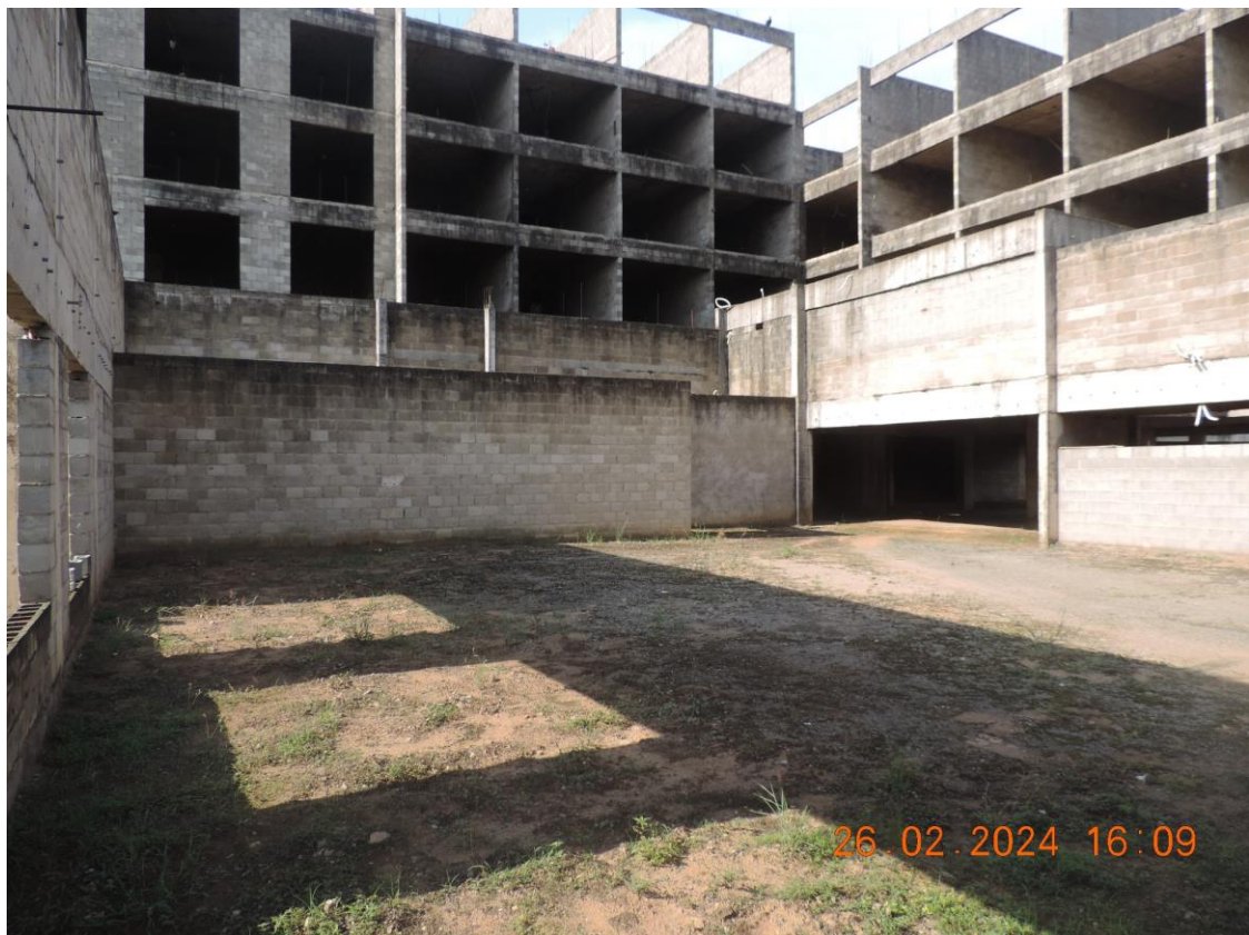
FOTO Nº 24 – PAVIMENTO TERREO DA EDIFICAÇÃO, VISTA PARCIAL
