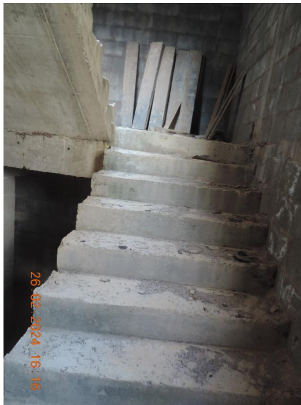
FOTO N° 38 – ESCADA DE ACESSO AO 3° PAVIMENTO
