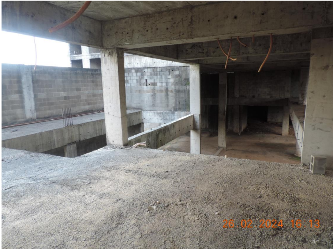
FOTO Nº 31 – 1º PAVIMENTO DA EDIFICAÇÃO, VISTA PARCIAL
