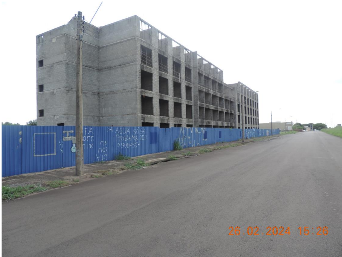
FOTO Nº 03 – VISTA EXTERNA DO IMÓVEL, TOMADA DE OUTRO ÂNGULO
