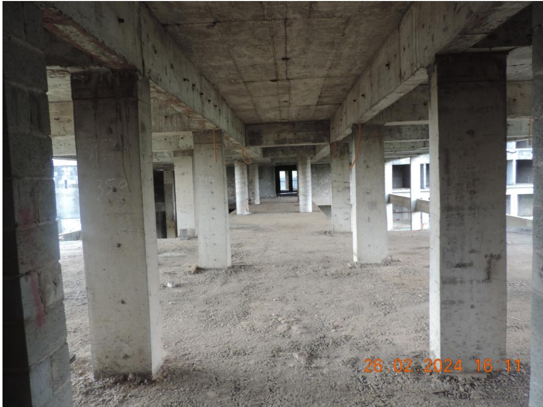
FOTO Nº 27 – 1º PAVIMENTO DA EDIFICAÇÃO, VISTA PARCIAL
