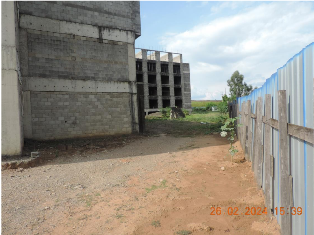
FOTO N° 11 – VISTA INTERNA DO IMÓVEL, POR OUTRO ÂNGULO
