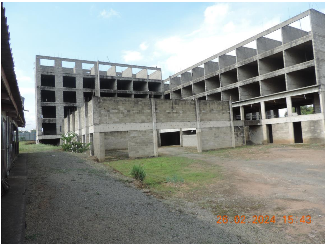
FOTO N° 14 – VISTA INTERNA DO IMÓVEL, POR OUTRO ÂNGULO
