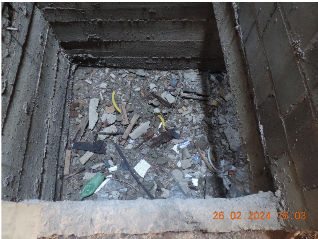
FOTO Nº 20 – PAVIMENTO TERREO DA EDIFICAÇÃO, VISTA PARCIAL
