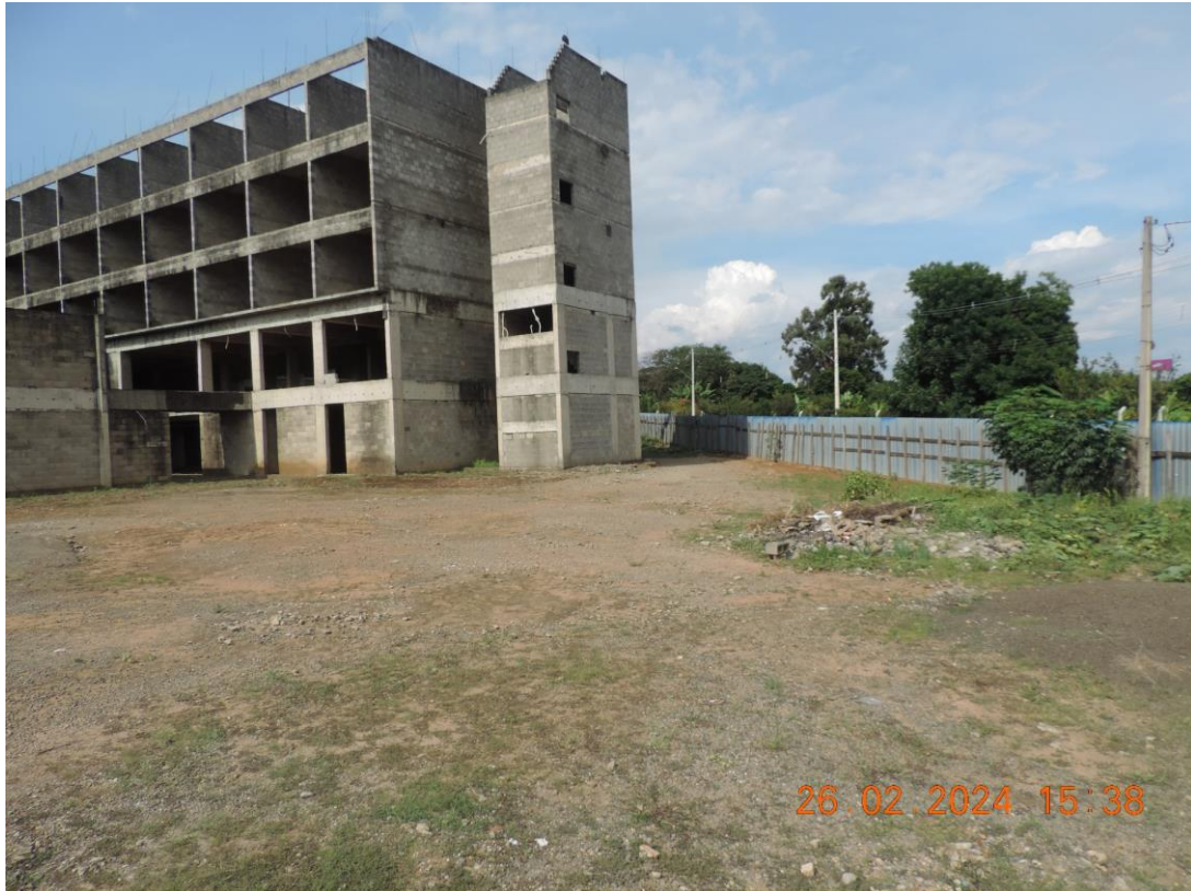
FOTO N° 09 – VISTA INTERNA DO IMÓVEL, POR OUTRO ÂNGULO
