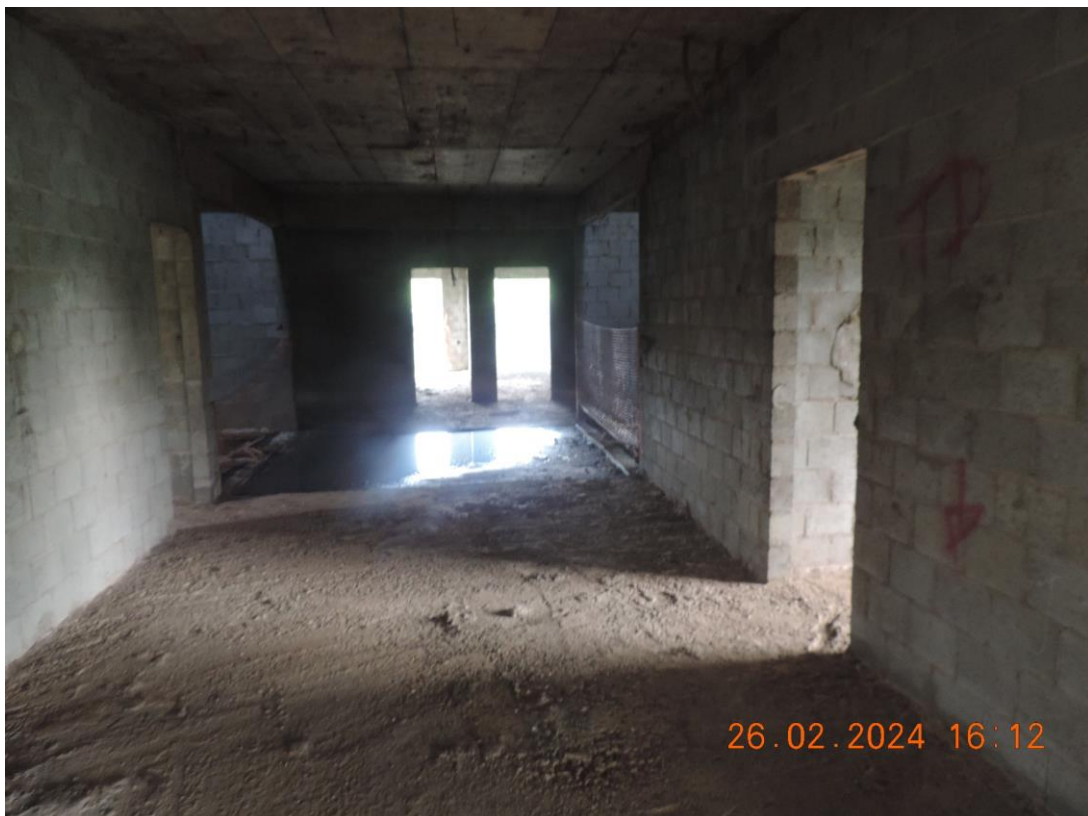
FOTO Nº 30 – 1º PAVIMENTO DA EDIFICAÇÃO, VISTA PARCIAL
