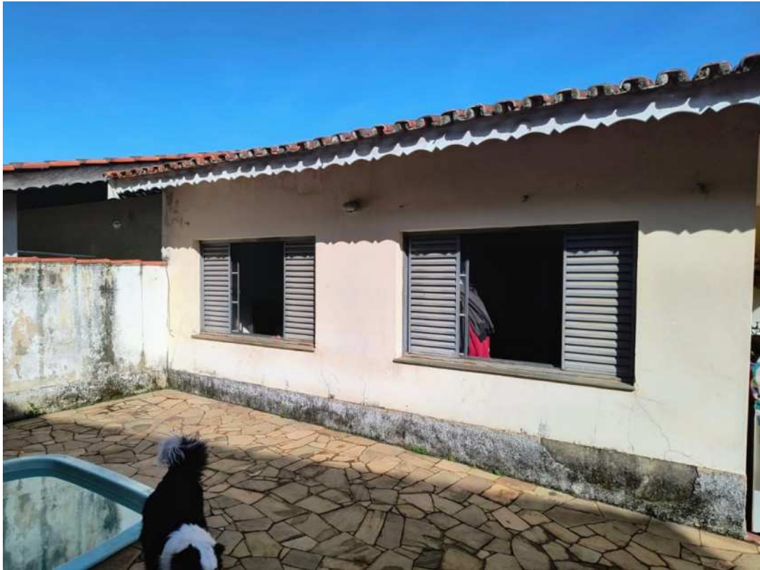
FOTO Nº 09 – FUNDOS DA EDIFICAÇÃO PRINCIPAL
