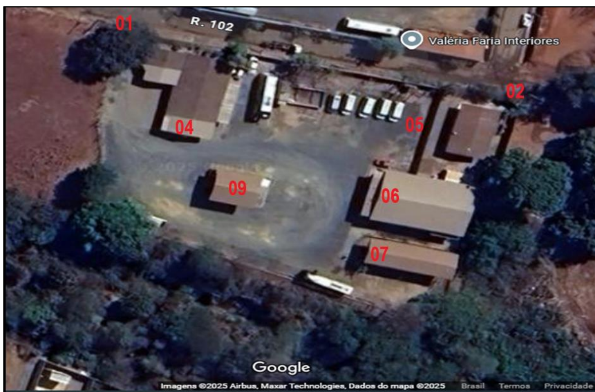
Vista aérea dos lotes 04 e 05 da quadra 48. Disponível em: < https://www.google.com/maps/@-17.8016731,-50.9448921,1280m/data=!3m1!1e3?entry=tu&g_ep=EgoyMDI1MDExNS4wLWlKMDS0ASAFQAw%3D%3D >. Acesso em: 18 jan. 2025.
