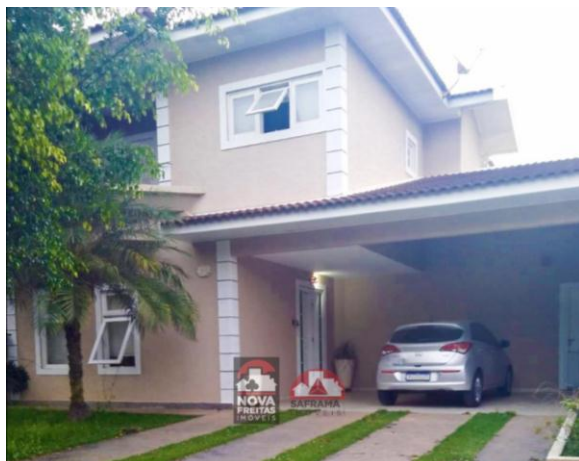
Foto 1. Vista da fachada do imóvel, frente à Rua Professor Francisco Galvão Freire.
