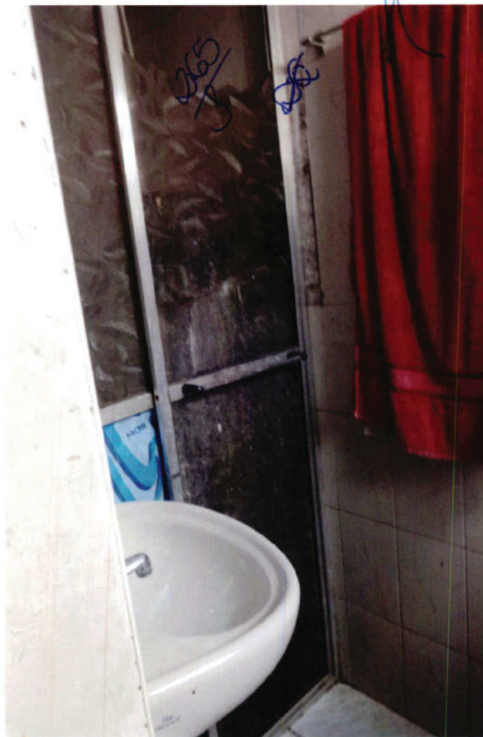
VISTA DO BANHEIRO I.
