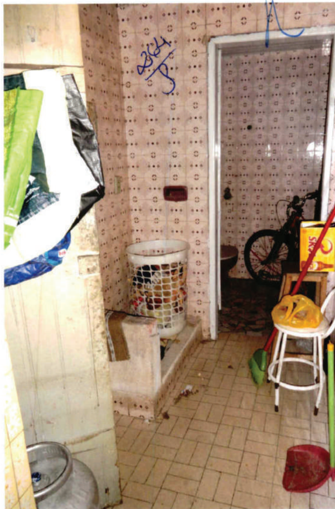
VISTA DO "HALL" INTERNO.
