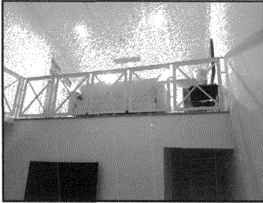
Detalhe do mezanino na suite
