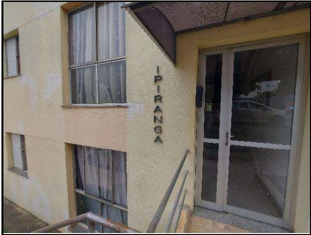
Identificação do Imóvel IDENTIFICAÇÃO DO IMÓVEL
