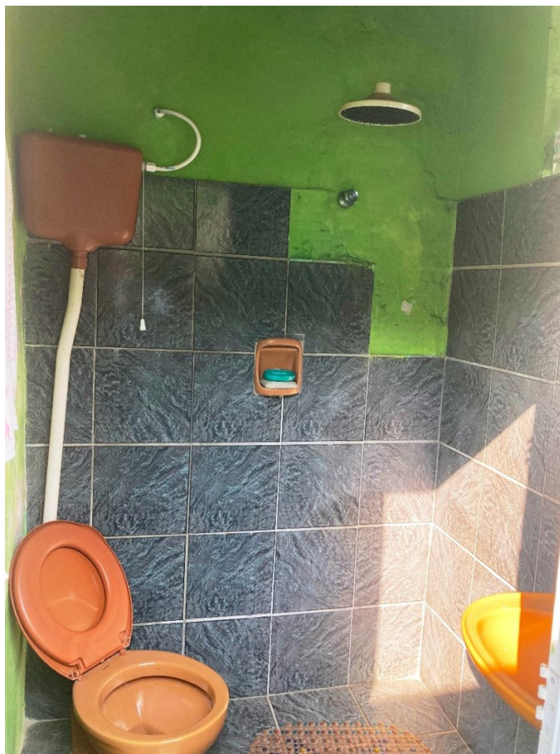
Foto 06 – Vista do banheiro externo
