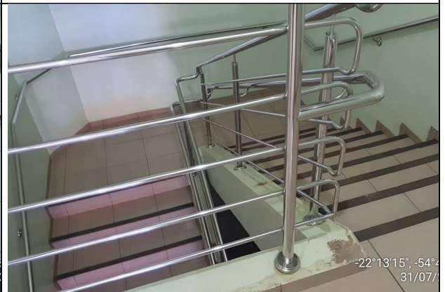
Acesso por escadas ao apartamento – 3º andar
