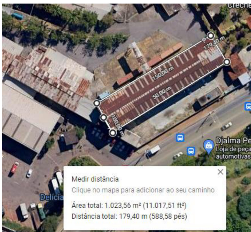
Foto 1: 1º galpão da frente.
