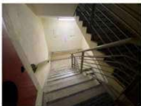
Foto 34 - Vista da escada entre o subsolo e o 3º andar.
