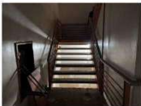
Foto 52 – Vista da escada de acesso ao 5º andar.
