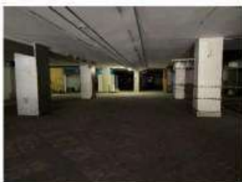
Foto 30 – Outra vista do 2º andar.
