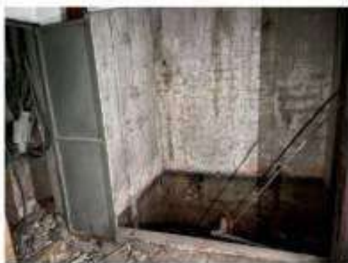
Foto 1 – Vista parcial do vão do elevador, situado no subsolo do imóvel objeto da ação.
