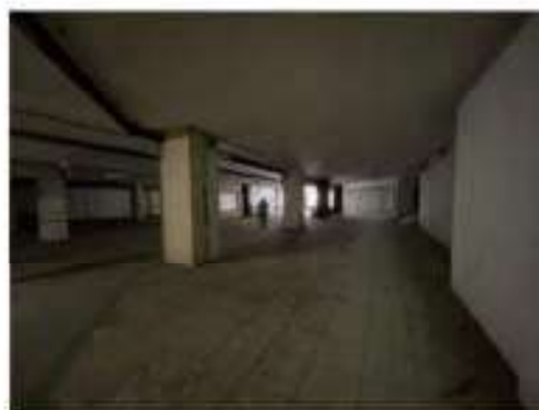
Foto 23 – Vista parcial do 2º andar do imóvel objeto da ação.
