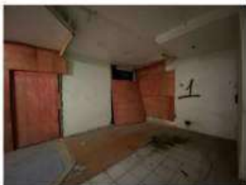
Foto 16 – Outra vista do 1º andar.
