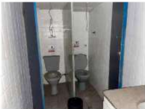
Foto 60 – Outra vista das instalações sanitárias.
