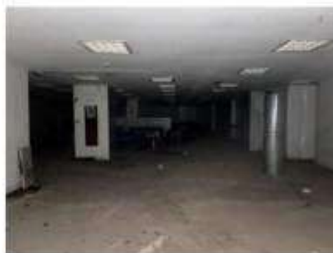
Foto 49 – Vista parcial do 4º andar.
