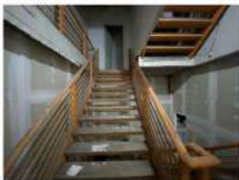
Foto 48 – Vista parcial da escada entre o 4º e o 5º andar.
