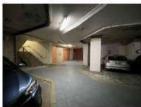
Foto 15 – Vista parcial do 1º andar, o local atualmente funciona como estacionamento.
