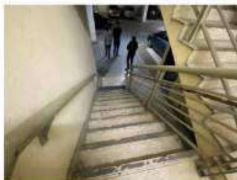
Foto 11 – Vista da escada entre o subsolo e o 1º andar.
