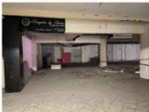
Foto 26 – Vista de espaço onde se localizava uma das lojas do antigo Shopping Bahia,
