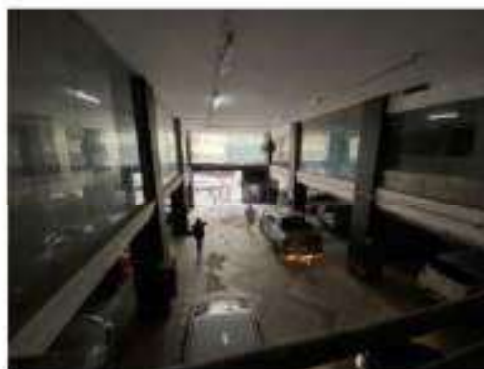
Foto 29 – Vista do hall de entrada no 1º andar. A vista foi tomada por um observador postado no 2º andar,
