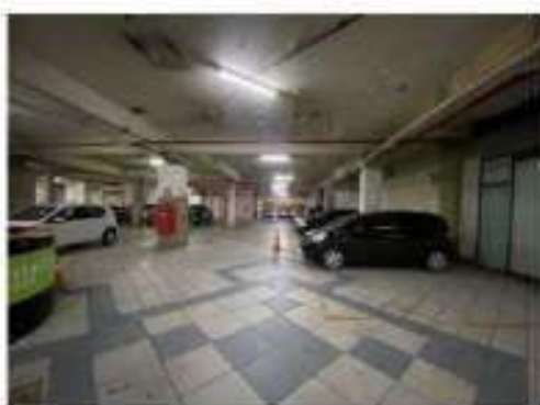
Foto 42 – Outra vista do 3º andar.
