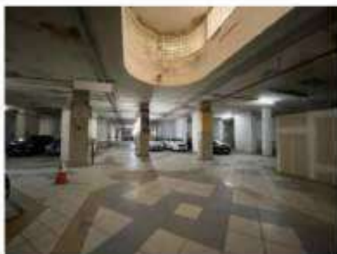
Foto 46 – Vista parcial do 3º andar.
