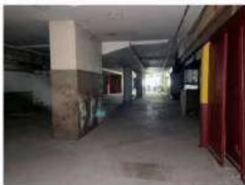
Foto 10 – Vista parcial do 1º andar.
