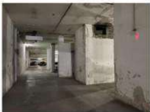
Foto 38 – Outra vista do 3º andar.
