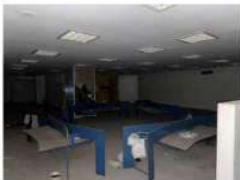
Foto 50 – Outra vista do 4º andar.
