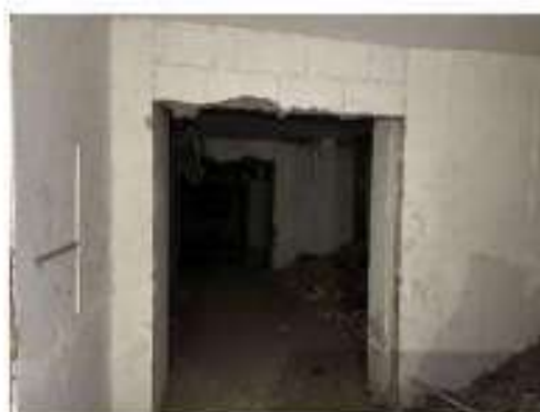
Foto 6 – Outra vista do subsolo.
