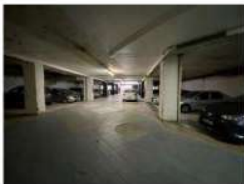
Foto 12 – Vista parcial do 1º andar do imóvel objeto da ação.
