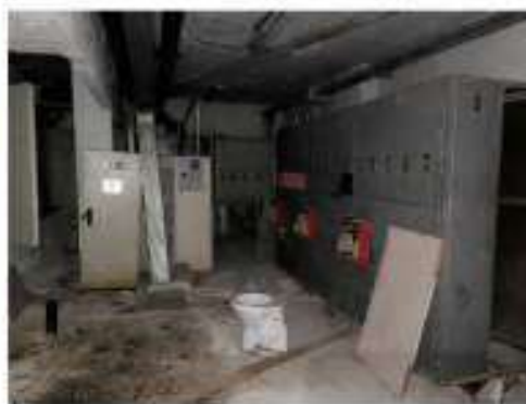
Foto 8 – Vista do espaço onde se localizava a subestação de energia.
