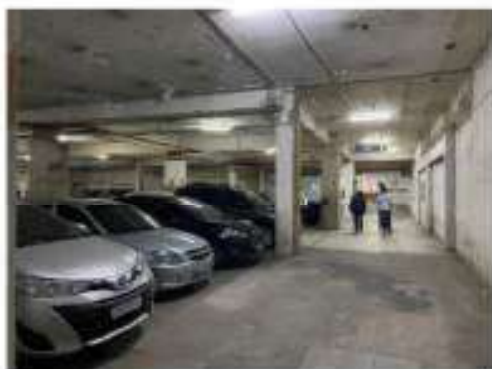
Foto 40 – Vista parcial do 3º andar.
