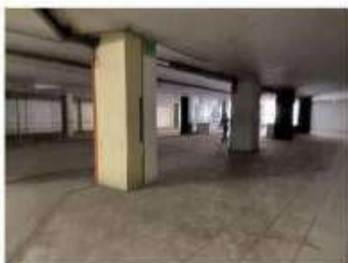
Foto 24 – Outra vista do 2º andar.
