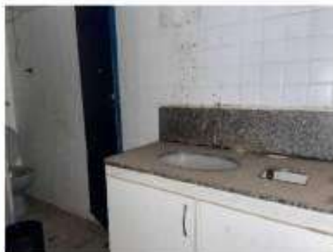
Foto 59 – Vista de uma das instalações sanitárias no 5º andar.
