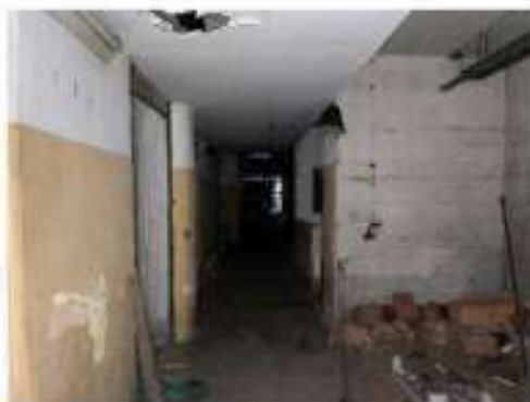
Foto 9 – Outra vista do subsolo no imóvel em questão.
