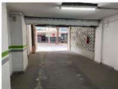
Foto 44 – Vista do acesso ao imóvel pela Rua Espírito Santo.
