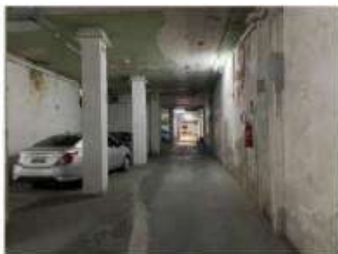
Foto 36 - Outra vista do 3º andar.
