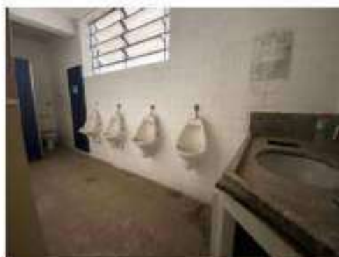
Foto 63 – Vista parcial de outra instalação sanitária no 5º andar.
