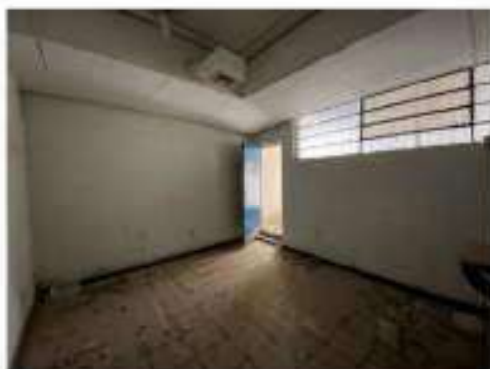
Foto 54 – Vista de uma das salas no 5º andar.
