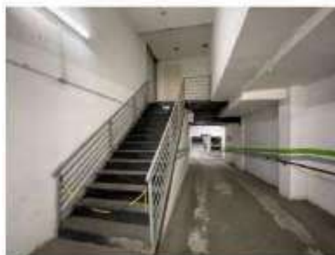
Foto 45 – Vista de escada de acesso ao 4 andar.
