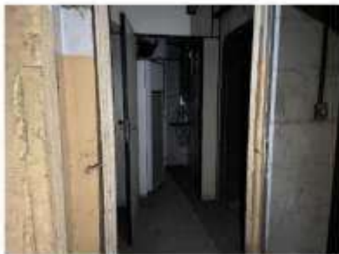
Foto 3 – Outra vista do subsolo.
