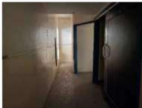
Foto 61 – Vista parcial do 5º andar.
