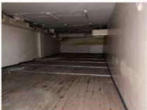
Foto 58 – Vista de uma das salas no 5º andar.
