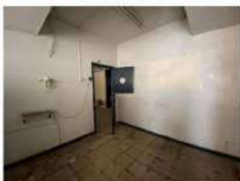
Foto 56 – Outra vista do 5º andar.
