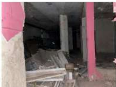
Foto 18 – Outra vista do 1º andar.
