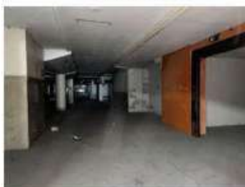
Foto 31 – Vista do hall de circulação no 2º andar.
