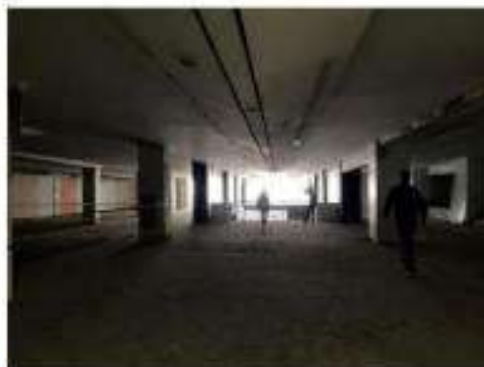
Foto 27 – Vistas parcial do 2º andar.
