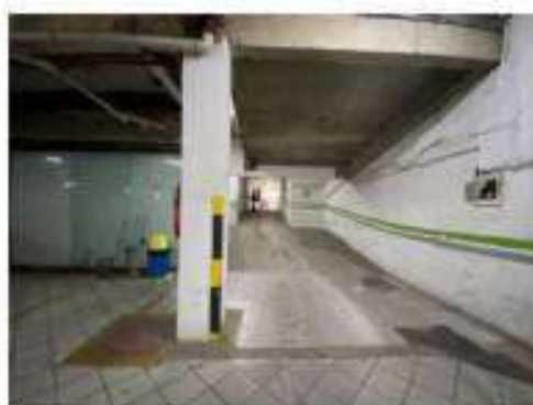
Foto 43 – Vista da rampa de acesso ao 3º andar pela Rua Espírito Santo.
