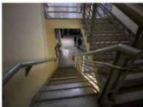
Foto 22 – Vista da escada entre o 1º e o 2º andar.
