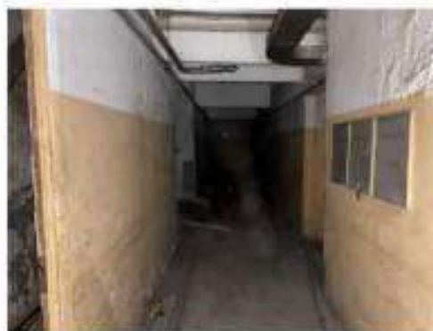
Foto 2 – Vista parcial do subsolo.
