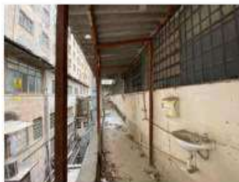
Foto 55 – Vista parcial da área externa do 5º andar.
