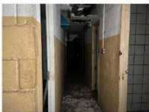
Foto 5 – Vista parcial do subsolo.
