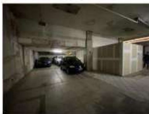
Foto 35 - Vista parcial do 3º andar do imóvel comercial objeto da ação.
