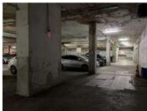
Foto 37 - Vista parcial do 3º andar.
