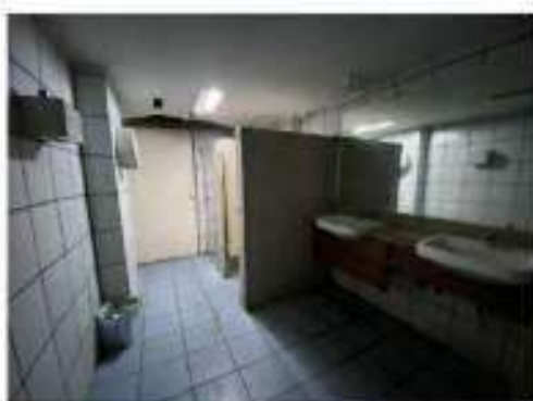
Foto 20 – Vista de instalação sanitária no 1º andar.
