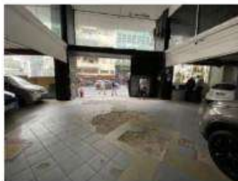
Foto 13 – Vista do acesso ao imóvel objeto da ação pelo 1º andar. O acesso se dá pela Rua da Bahia nº. 1022.
