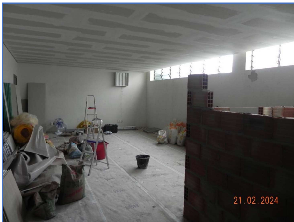
Imagem 13- Sala em reforma para conversão em quarto
