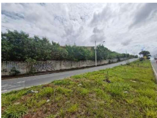
Foto 5 – Vista parcial da testada dos lotes 40, 41, 42 e 43 da quadra 06
