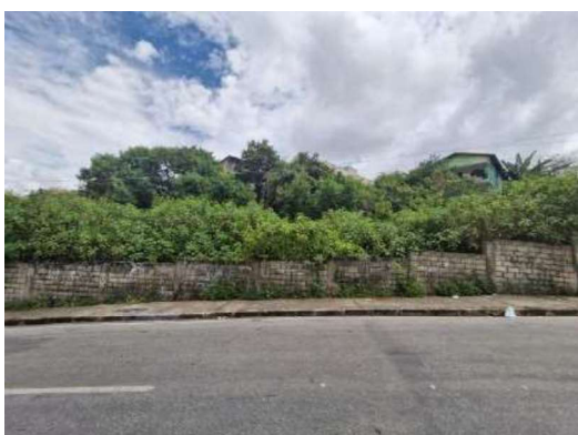
Foto 7 – Vista parcial da testada do lote 4 da quadra 06.
