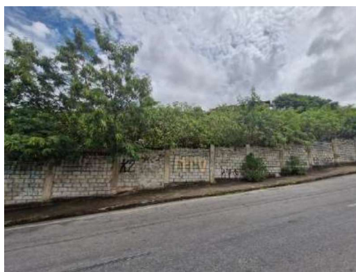
Foto 6 – Vista parcial da testada do lote 40 da quadra 06.
