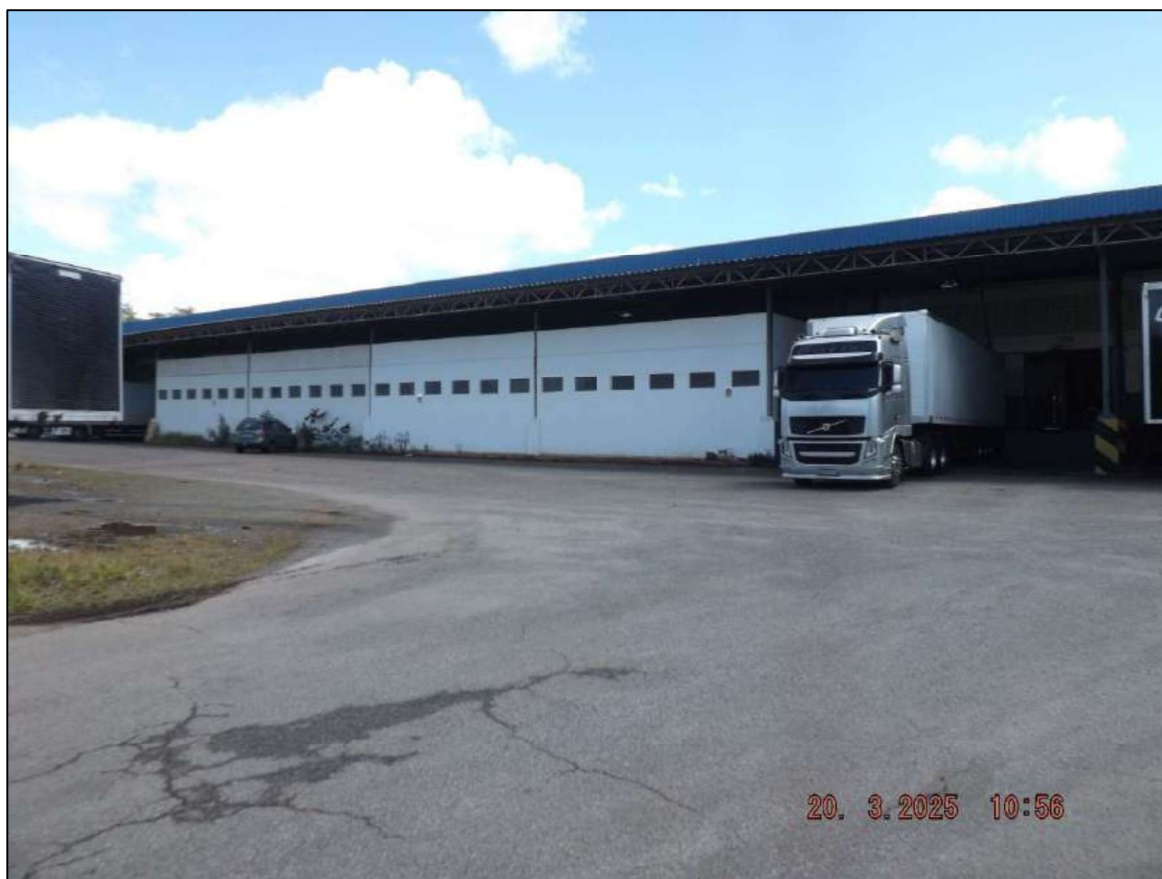
Figura 9: Fachada Galpão Industrial
