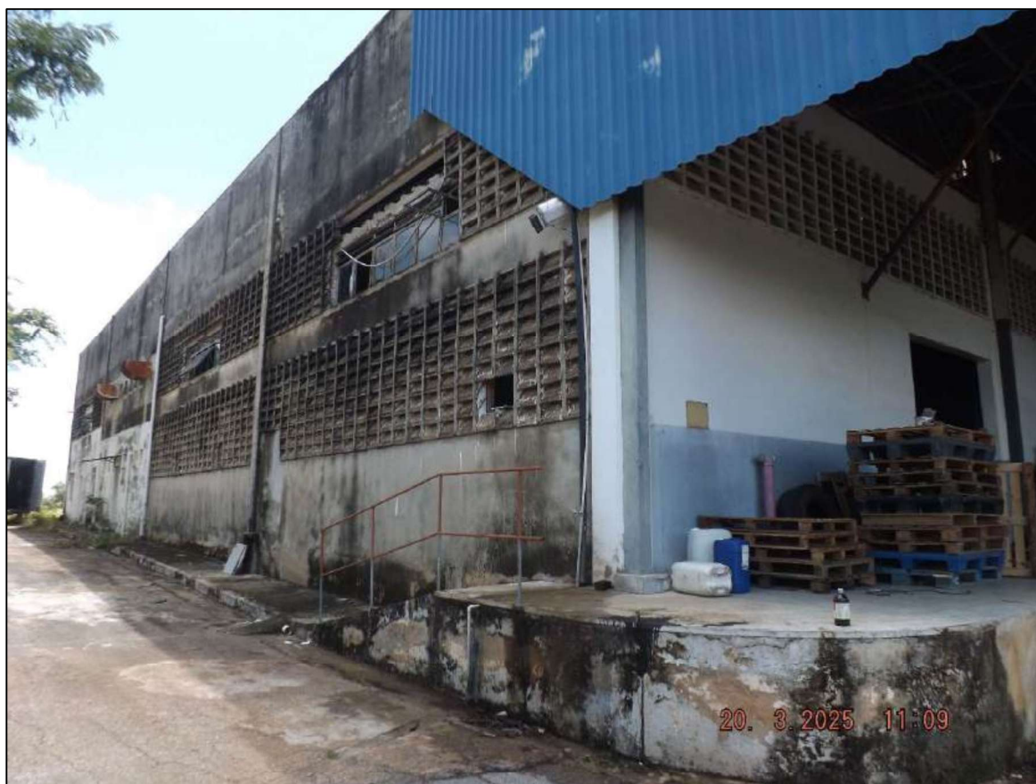
Figura 15: Lateral do Galpão Industrial
