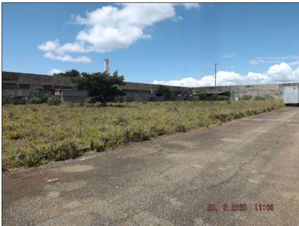
Figura 14: Fundos do Galpão Industrial
