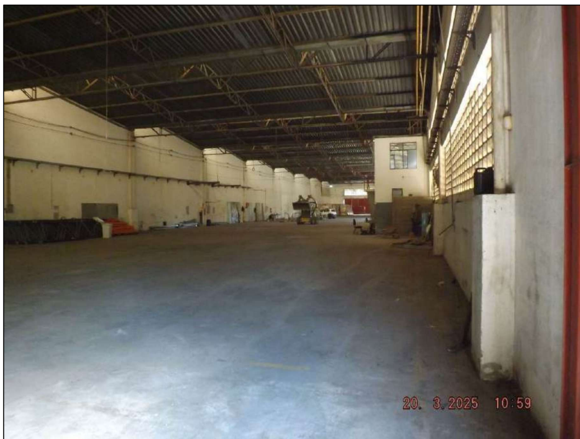
Figura 11: Interior Galpão Industrial
