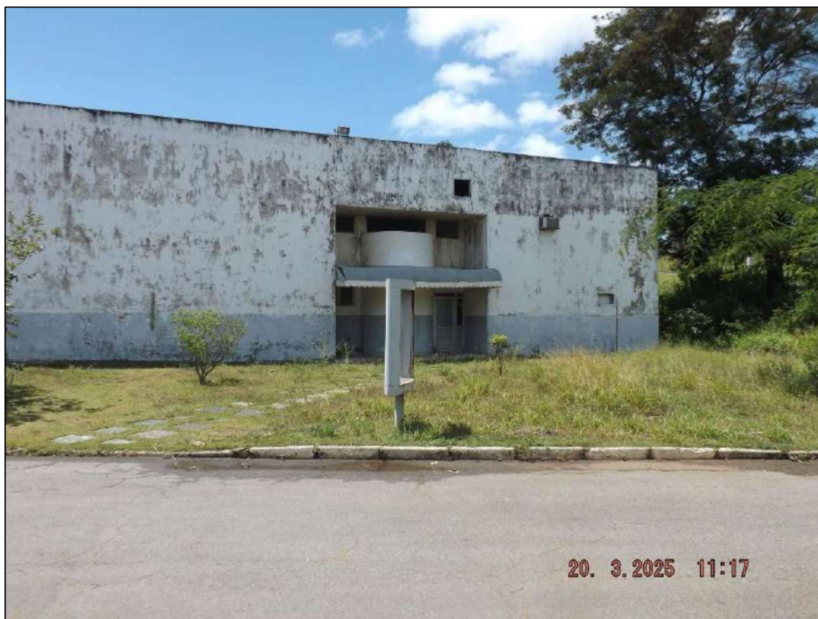
Figura 7: Fachada do prédio administrativo
