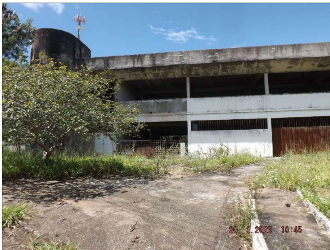
Figura 1: Fachada do Imóvel inacabado
