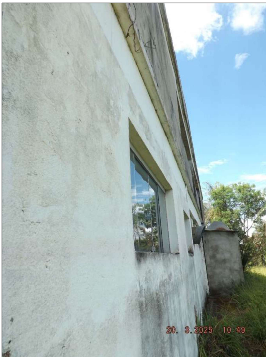
Figura 3: Lateral do Imóvel inacabado
