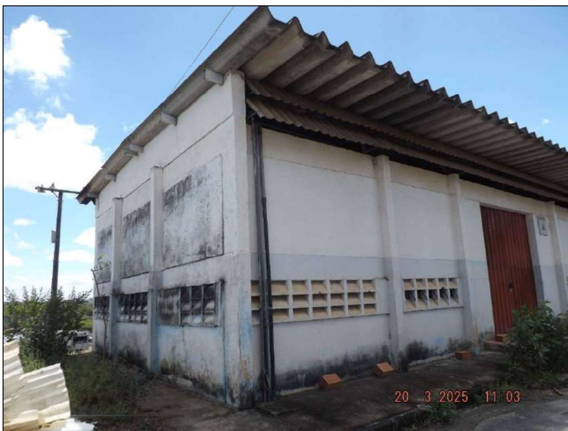
Figura 13: Anexo do Galpão Industrial
