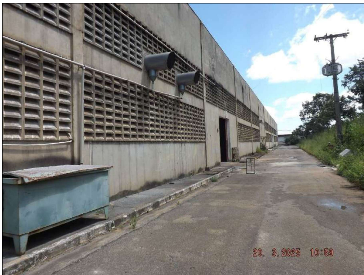
Figura 10: Lateral Galpão Industrial
