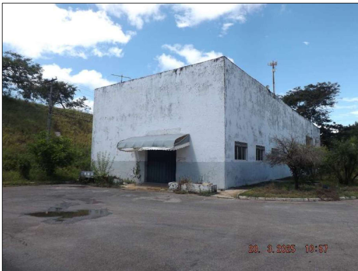
Figura 6: Fachada do prédio administrativo
