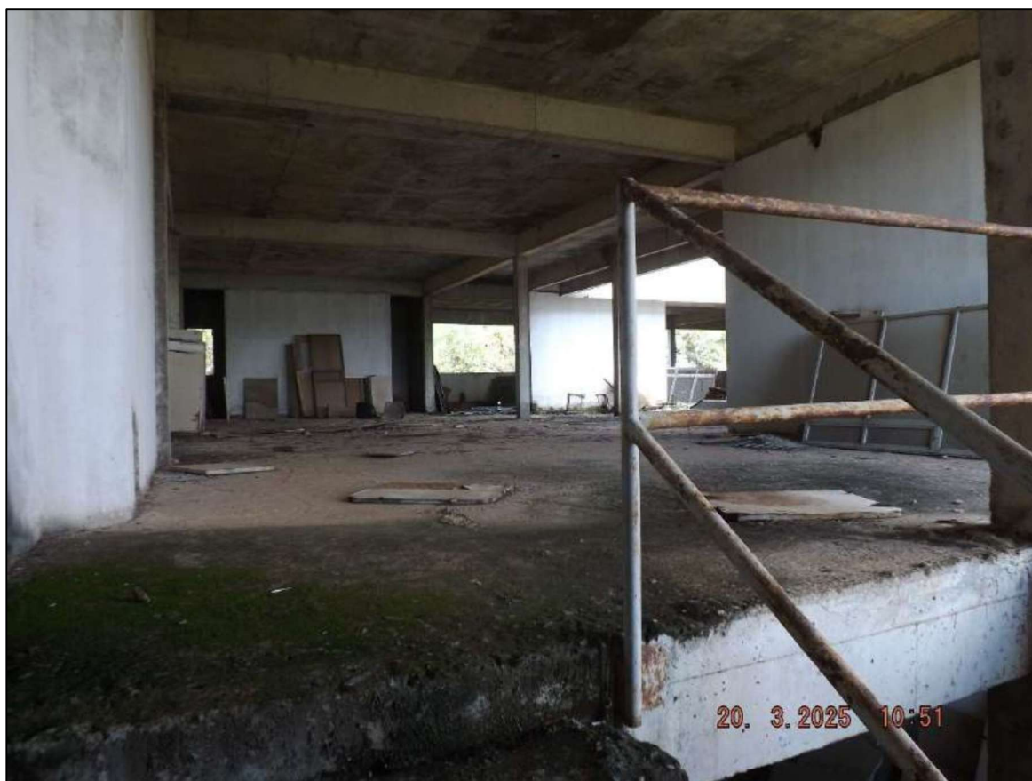
Figura 4: Interior do Imóvel inacabado
