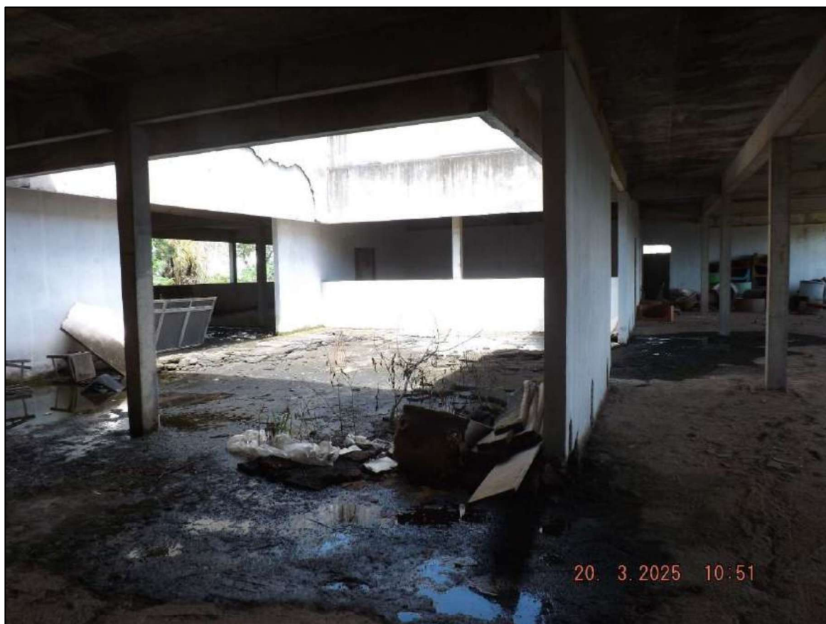
Figura 5: Interior do Imóvel inacabado
