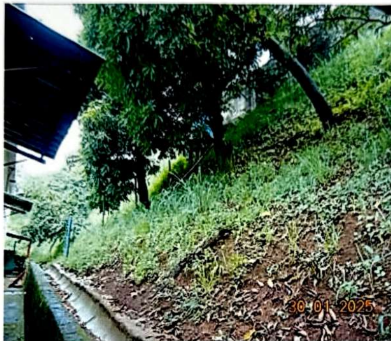
Fotografia 27 – Vista do talude de fundos da loja
