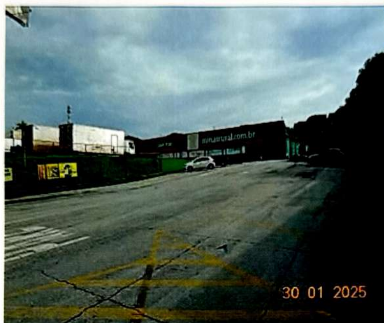
Fotografia 1 – Vista geral da fachada frontal do imóvel objeto desta lide
