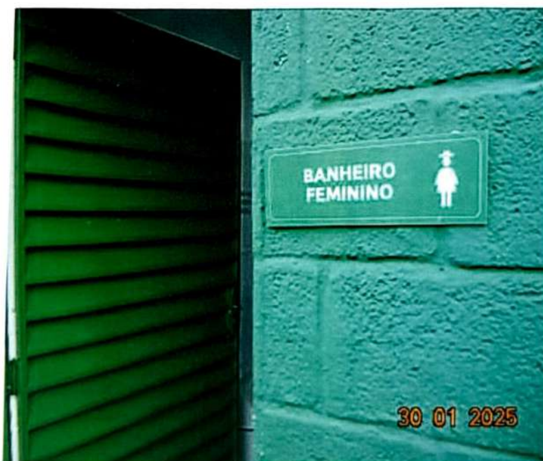
Fotografia 10 – Vista da entrada para o banheiro feminino
