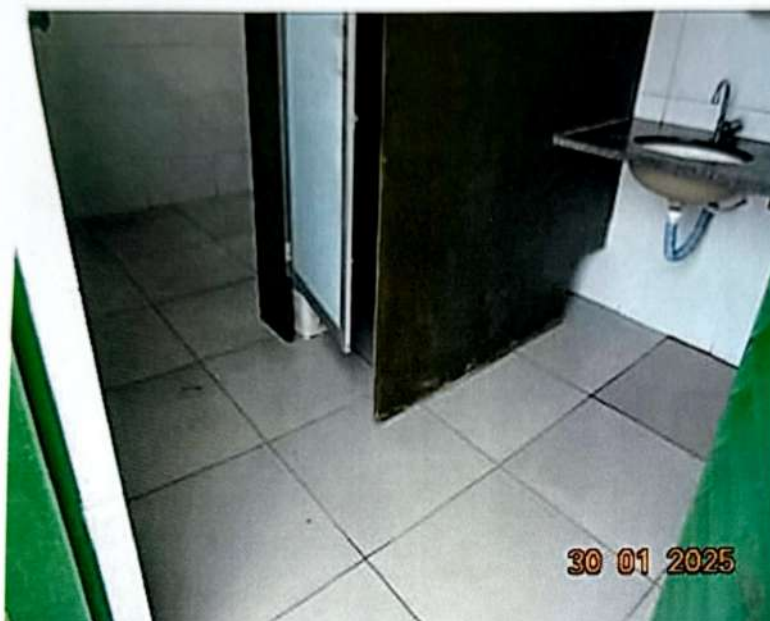
Fotografia 9 – Vista do piso do banheiro masculino
