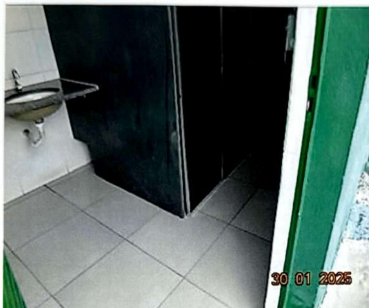
Fotografia 11 – Vista do piso do banheiro feminino
