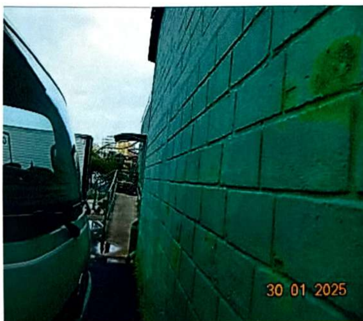
Fotografia 46 – Vista lateral da edificação
