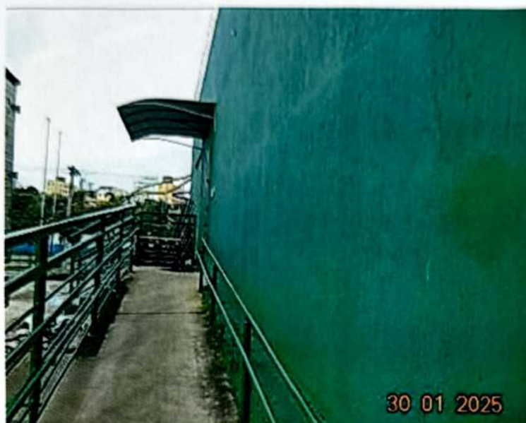
Fotografia 47 – Vista da escada de acesso cômodo de descarte de produtos vencidos
