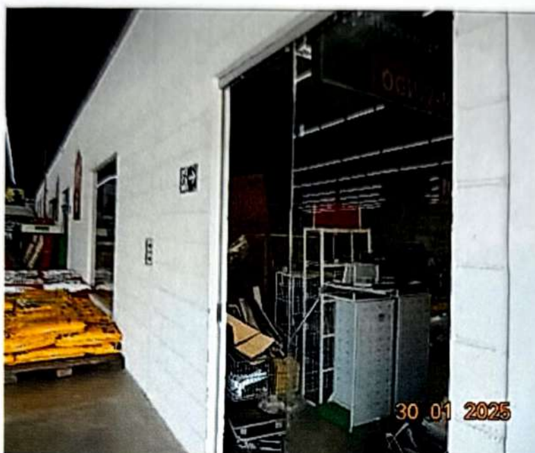
Fotografia 15 – Vista da área de triagem
