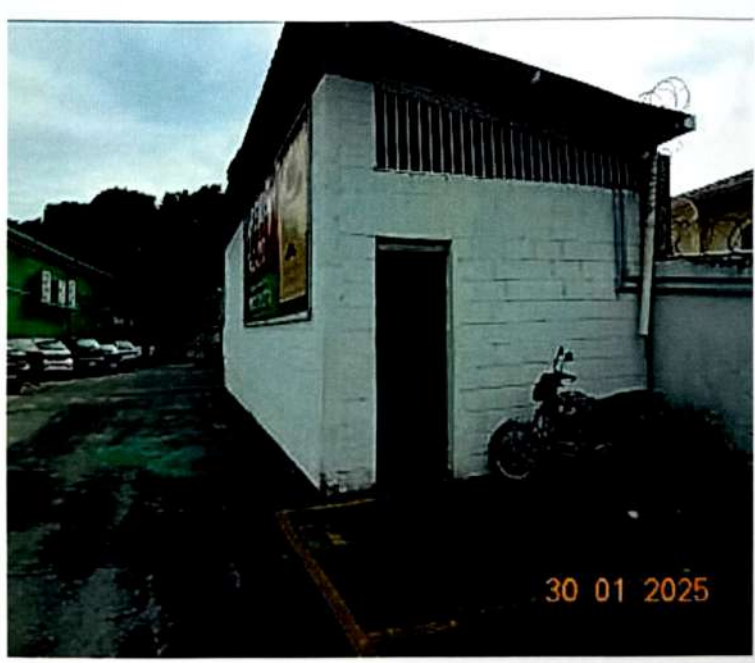
Fotografia 4 – Vista do refeitório e vestiário
