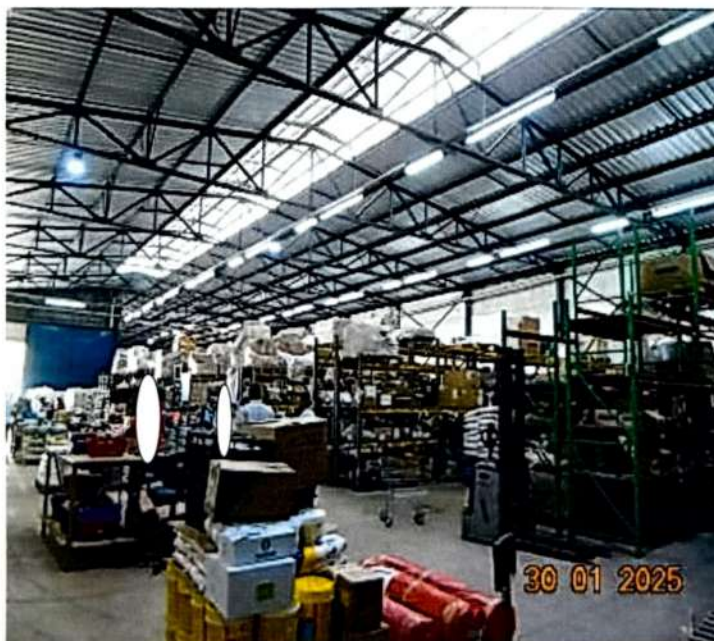
Fotografia 40 – Vista geral da seção armazenamento
