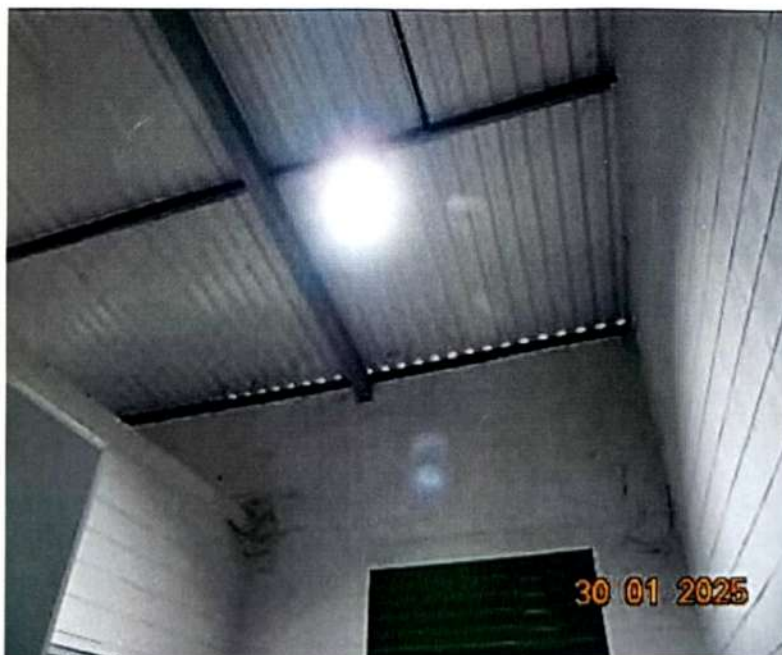
Fotografia 34 – Vista do teto dos banheiros
