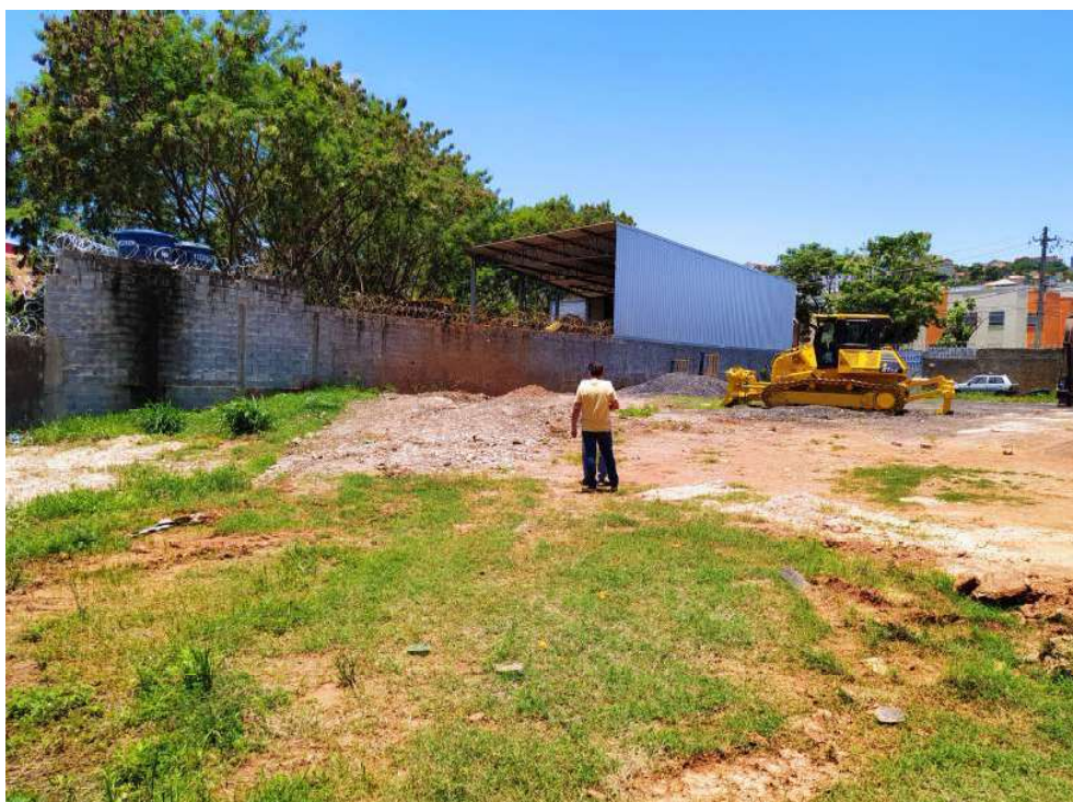
Imagem 07: Foto Visão Panorâmica do Imóvel Avaliando Visto do Fundo
