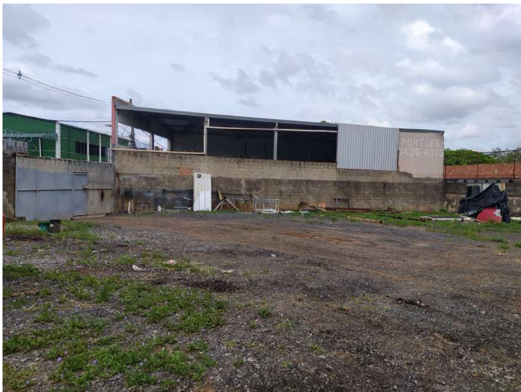
Imagem 10: Foto da Vista do Lote 03, Lateral Esquerda do Imóvel Avaliando.
