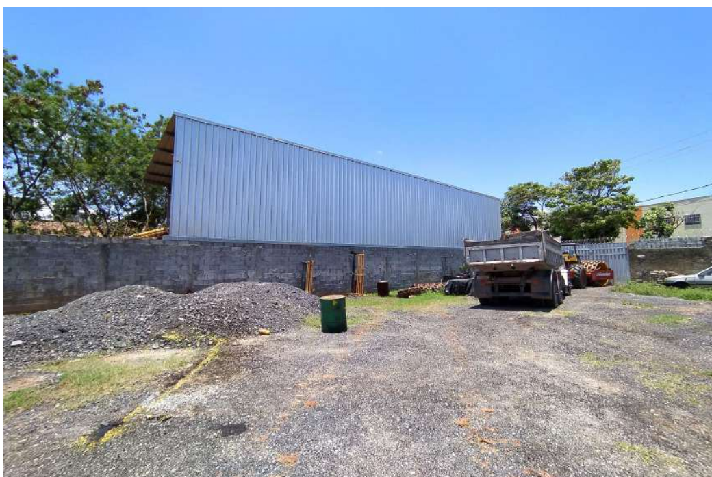
Imagem 16: Foto Interior e Frente do Imóvel Avaliando visto do fundo
