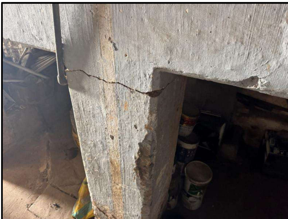
Foto: Vista parcial interna
