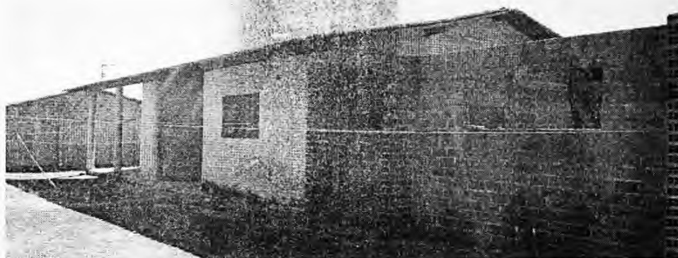
FOTO 03(Vista da parte dos fundos da Clínica onde fica a lavanderia e três apartamentos inacabados)
