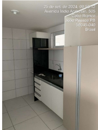
Foto 13: Cozinha / Área de serviço apartamento 510
