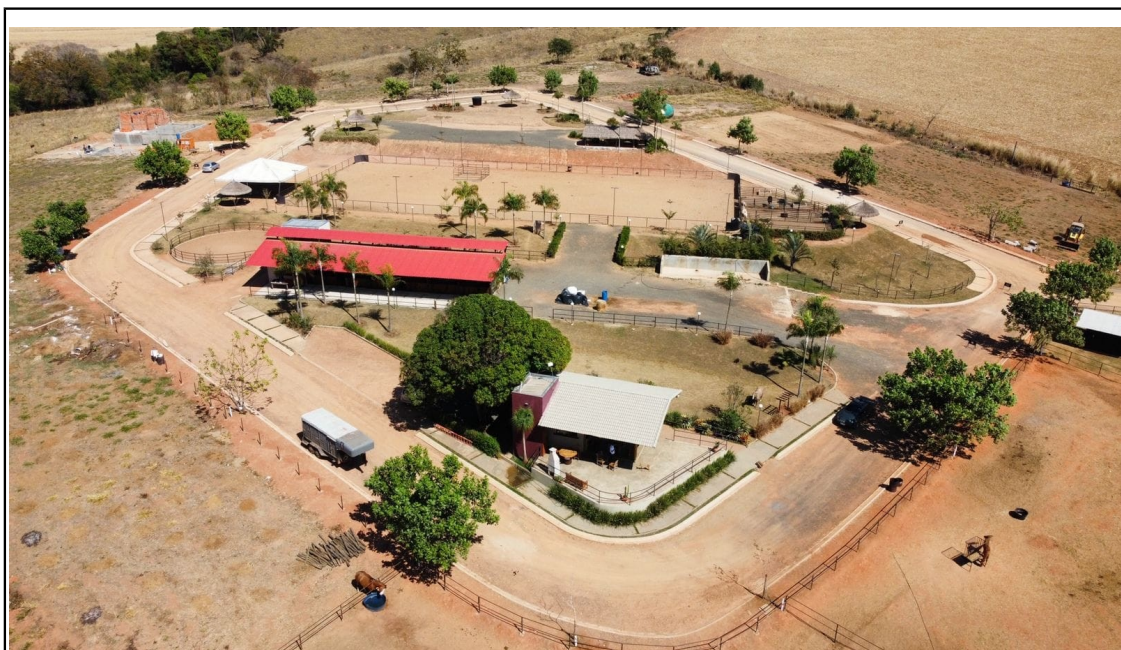
Figura 1: Vista àrea loteamento
