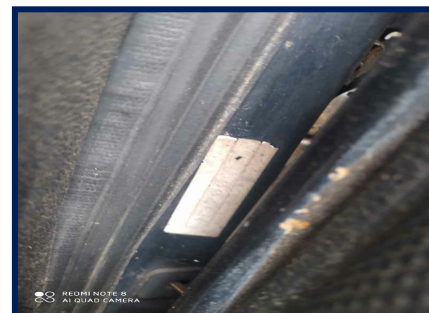
Foto eta coluna
