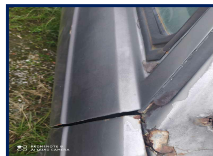
Foto eta coluna
