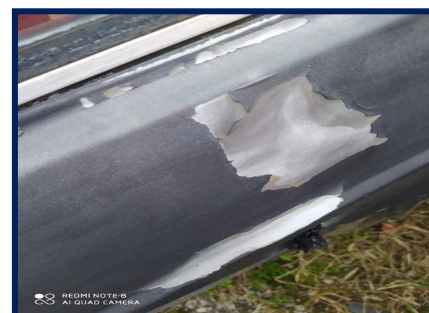
Foto eta coluna
