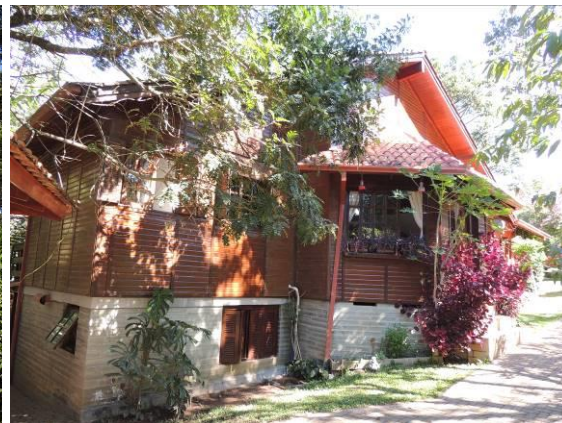
FOTOS 09 – fachada frontal
