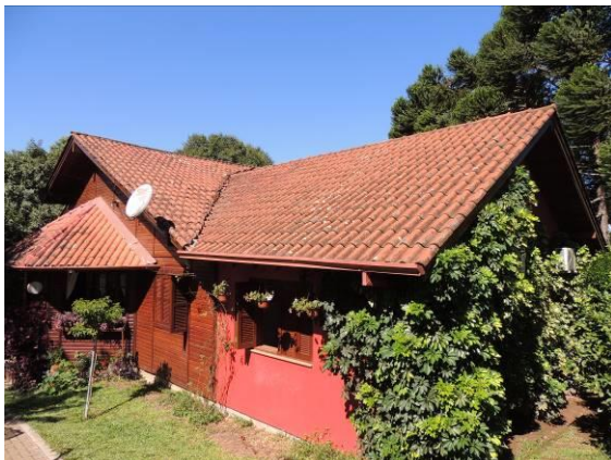
FOTOS 08 – fachada frontal
