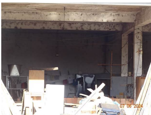
Foto 12: Vistas gerais do depósito.
