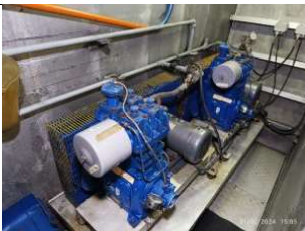
87. Compressores de ar principais
