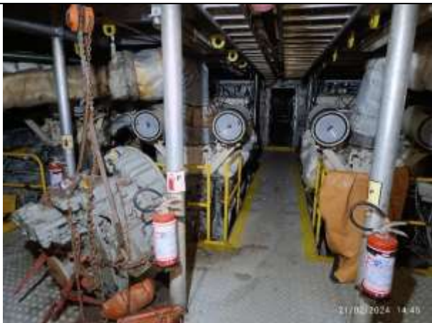
77. Praça de máquinas
