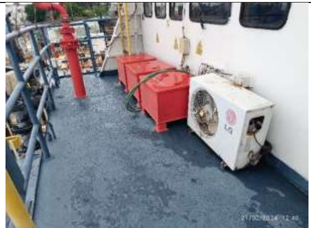
18. Split e caixas de baterias no convés do passadiço
