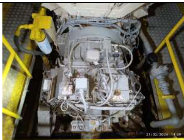
102. Redutora do motor propulsor nº 2
