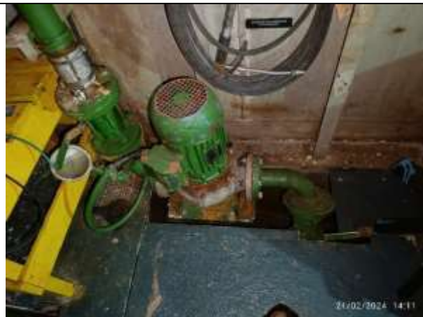
90. Bomba de arrefecimento do óleo hidráulico do propulsor azimuthal
