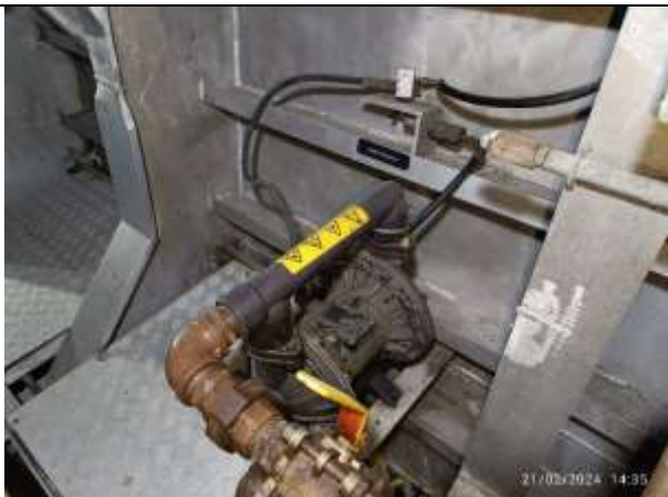
107. Bomba pneumática de transferência de óleo diesel
