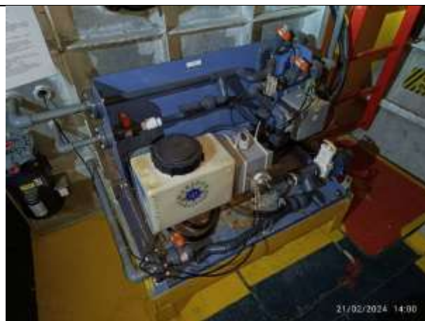
80. Unidade de tratamento de esgoto sanitário
