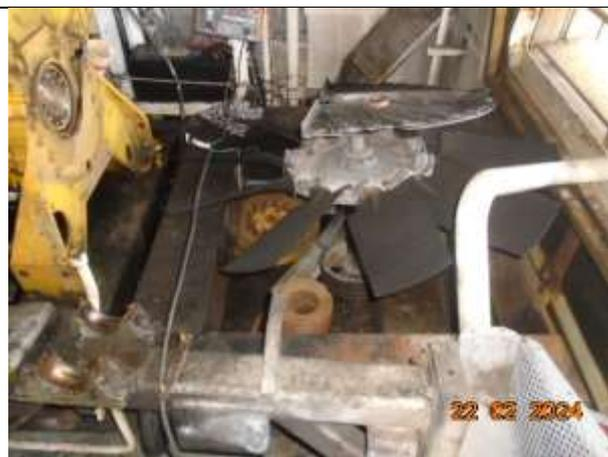
58. Radiador do motor diesel do grupo gerador de emergência removido para reparo
