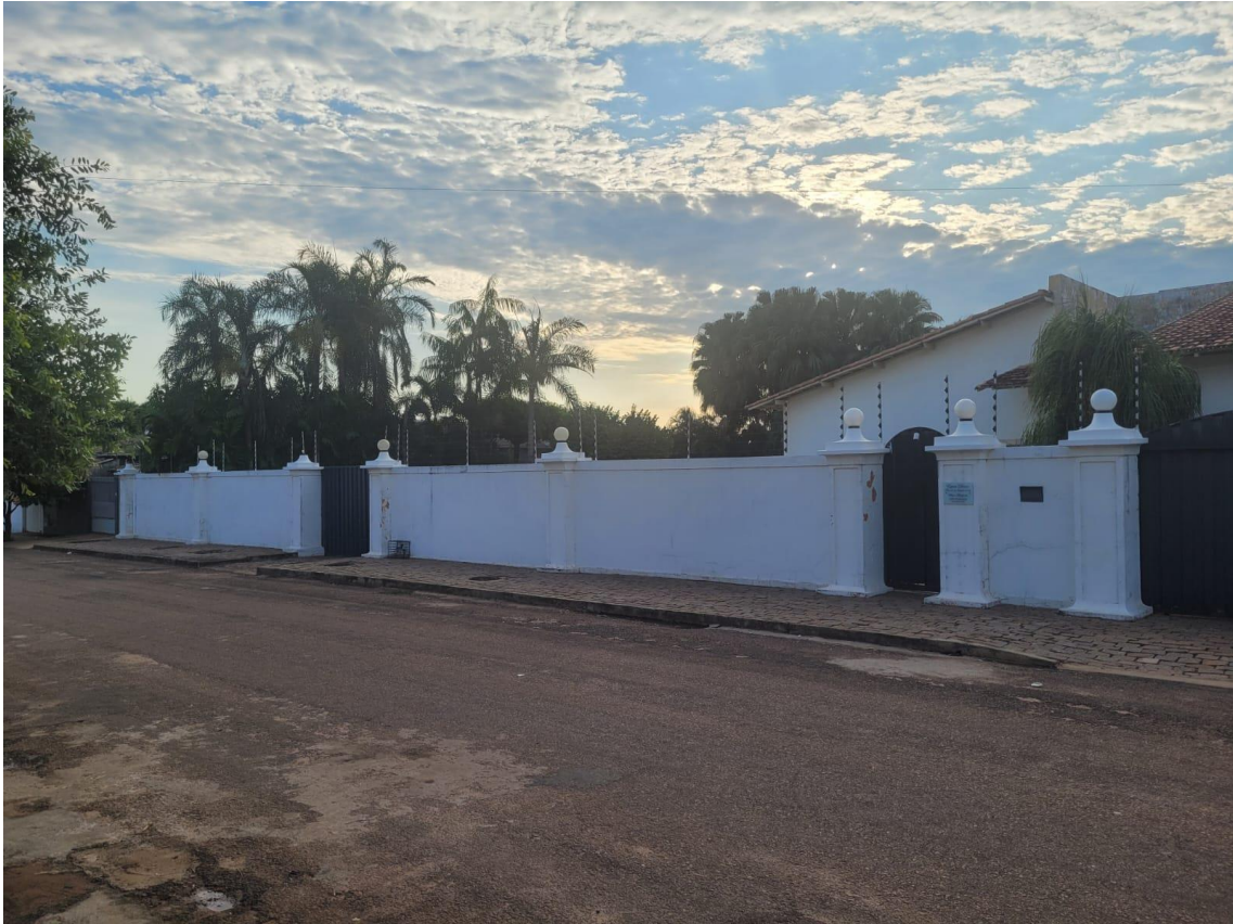
Vista da frente em toda a extensão do muro
