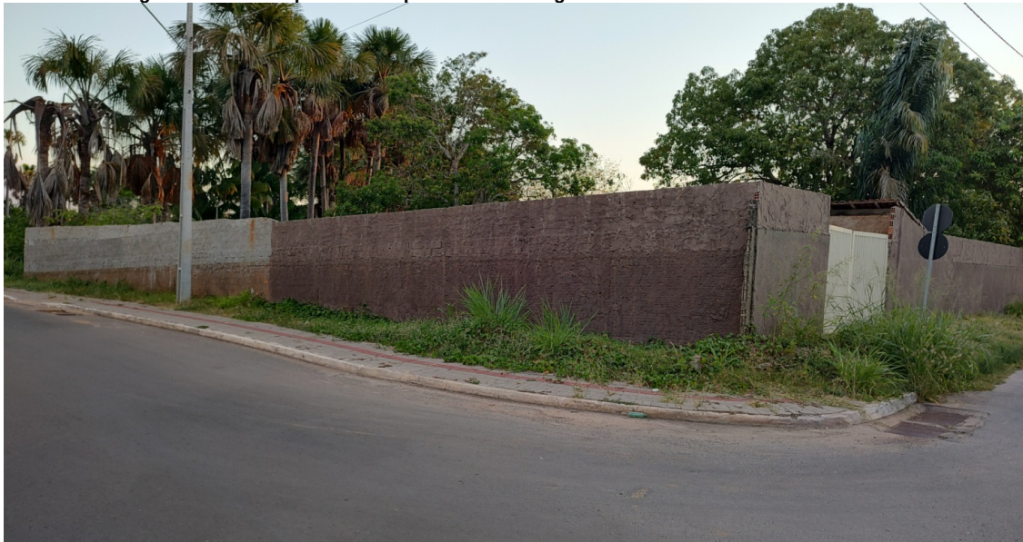
Imagem do imóvel a partir da esquina da Rua Araguari com a Rua Ademar Vicente Ferreira
