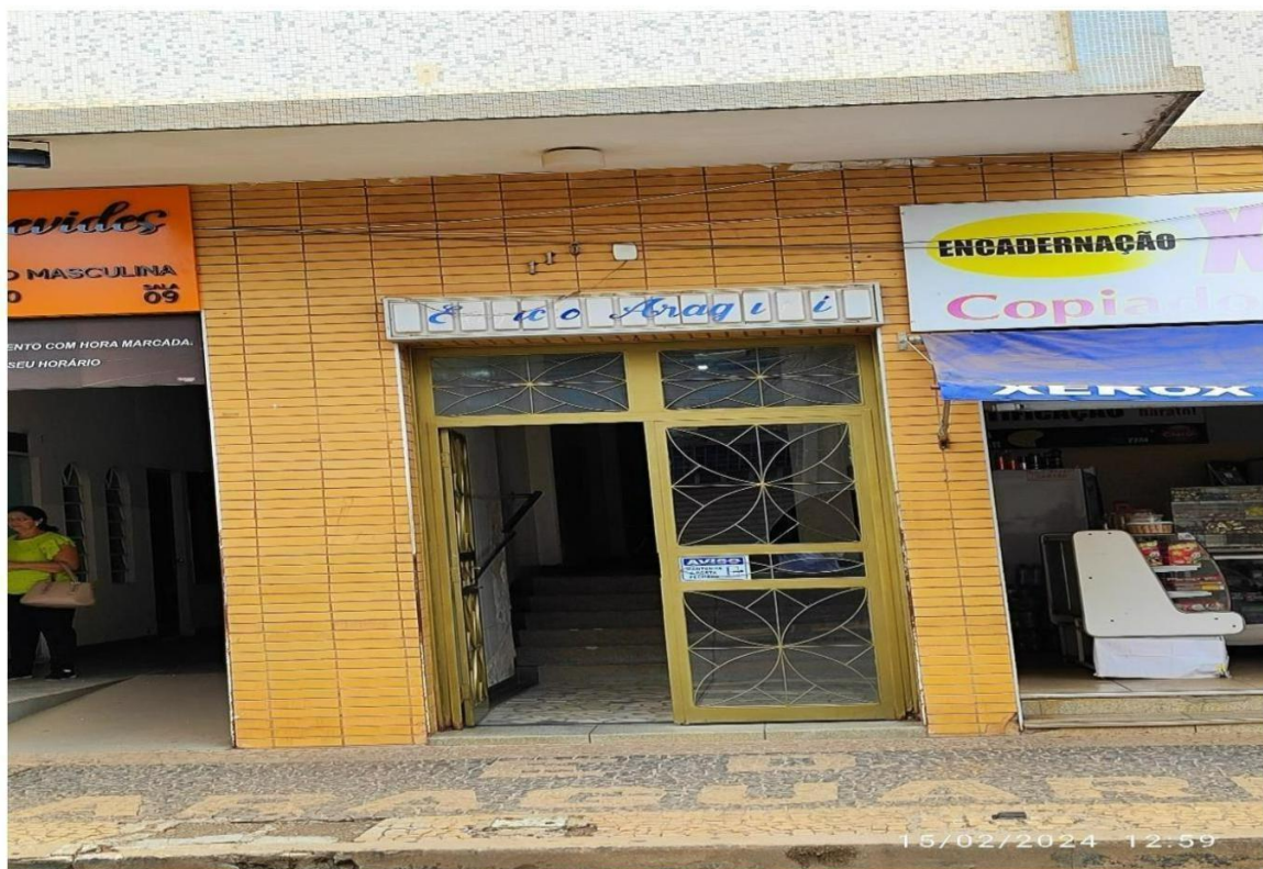
Foto 2: Entrada principal do imóvel.
