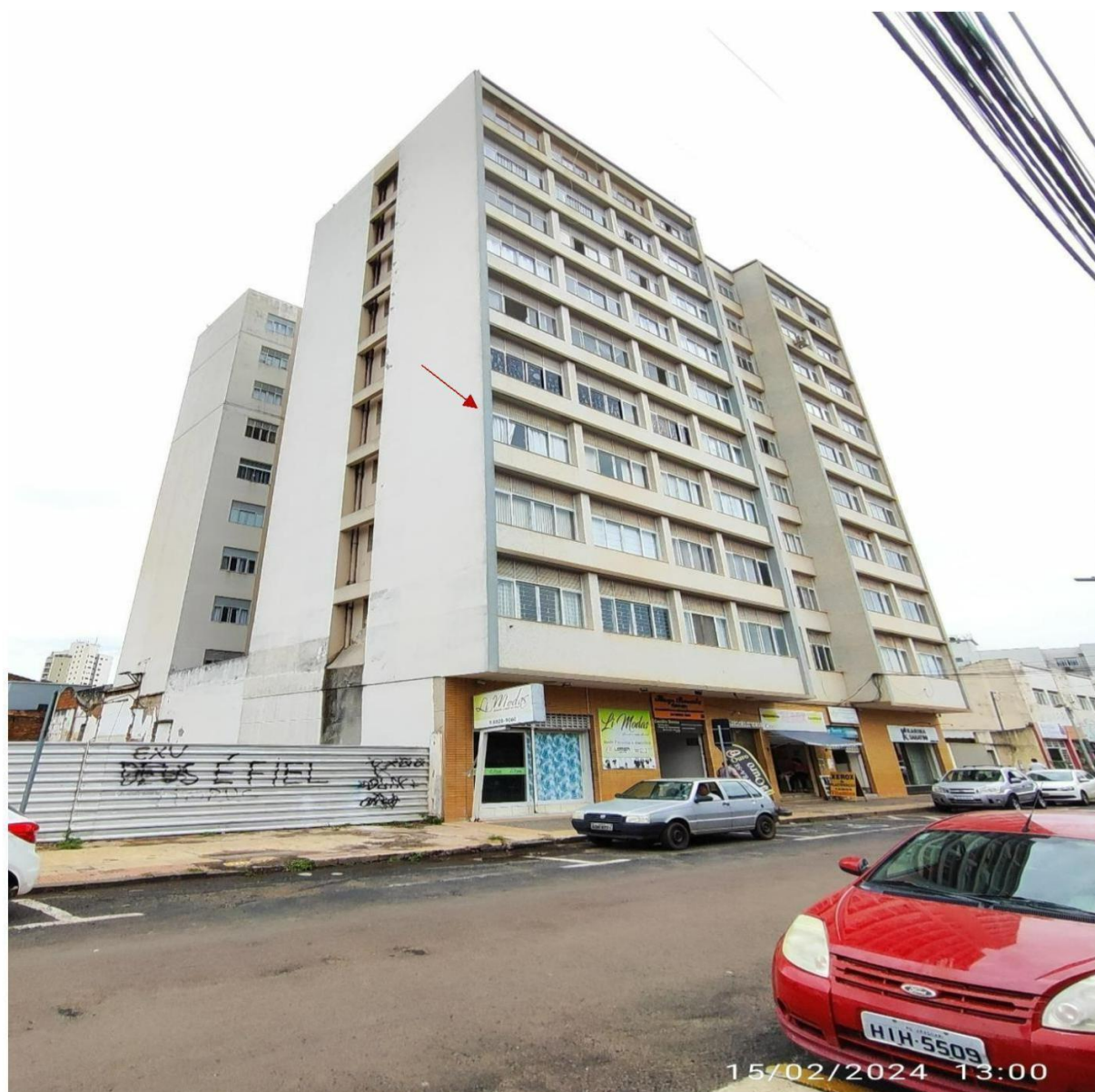
Foto 1: Frente do Imóvel
