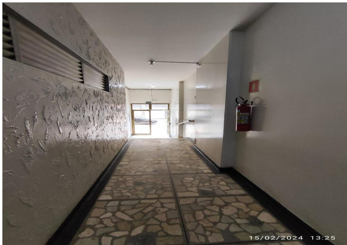
Foto 4: Visão interna do imóvel, térreo.
