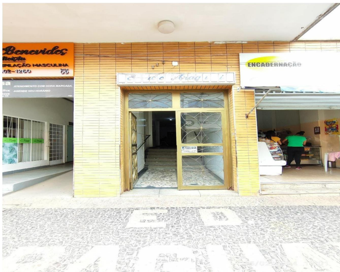
Foto 2: Entrada principal do imóvel.
