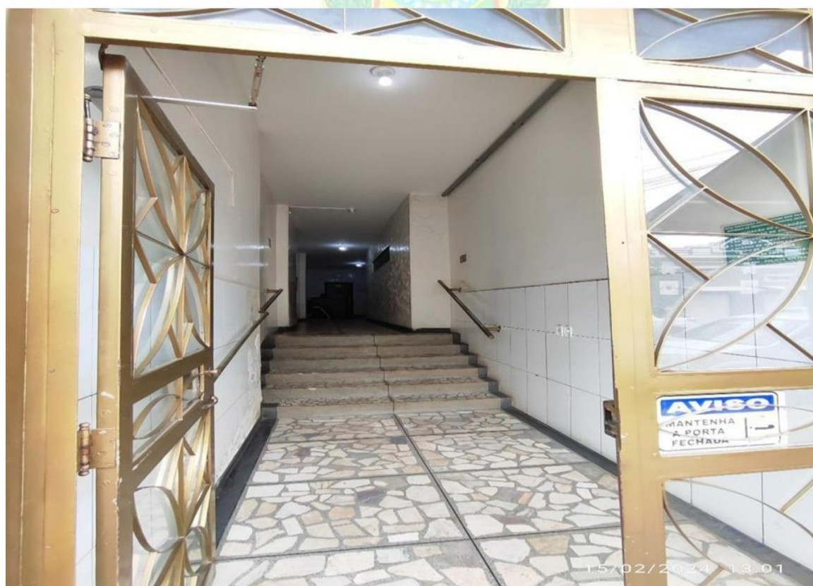
Foto 3: Visão do imóvel.
