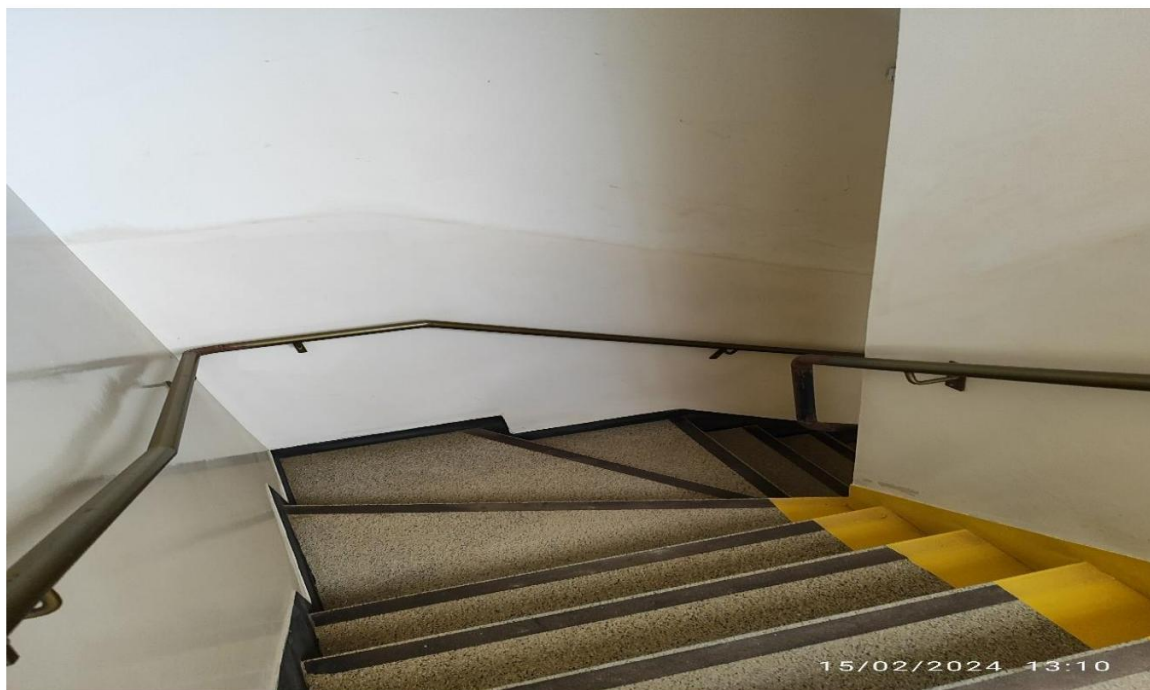
Foto 7: Caixa de escada.
