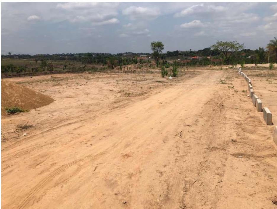
Área do estacionamento (em execução)
