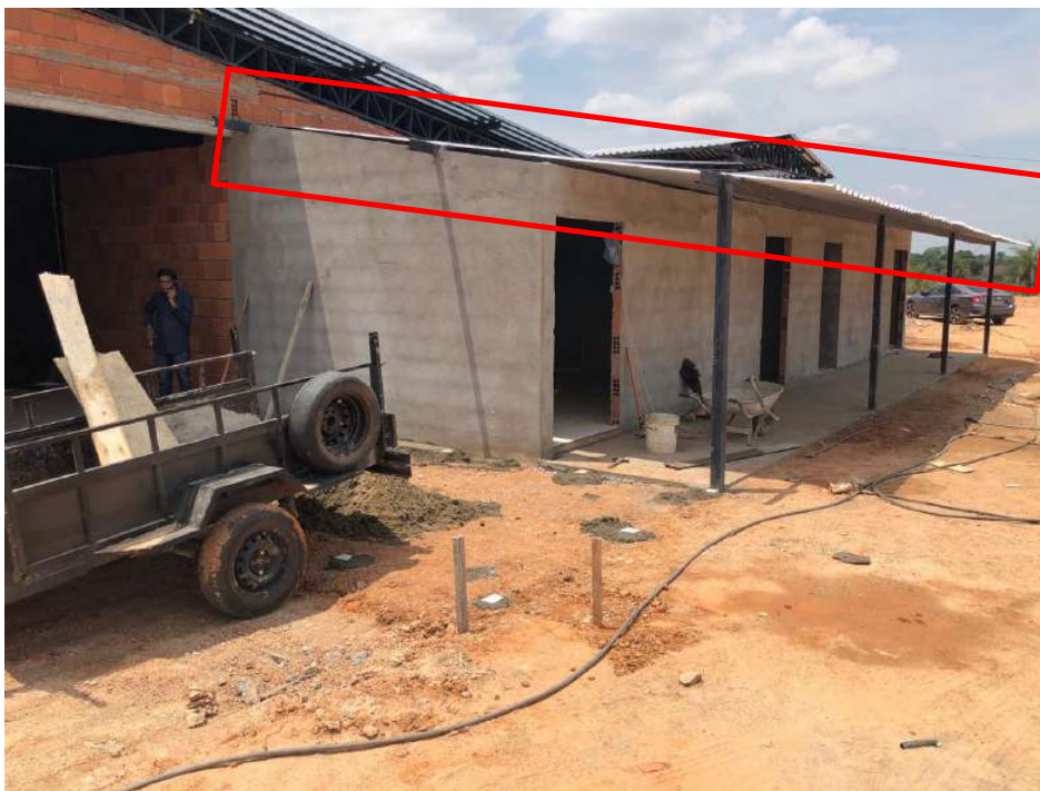
Vista dos fundos
