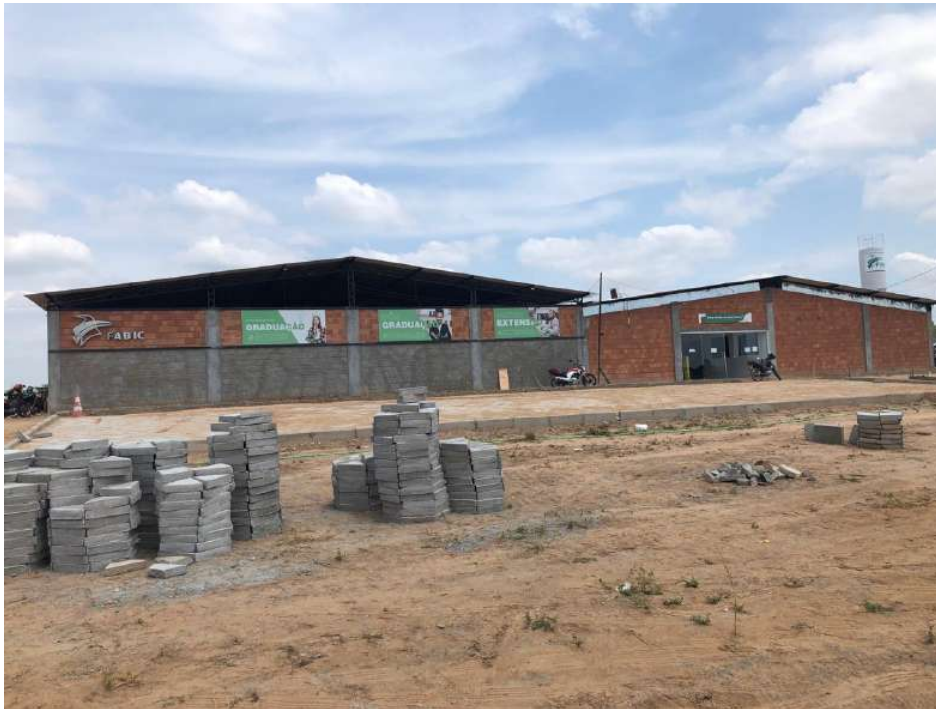
Fachada frontal (estacionamento em execução)
