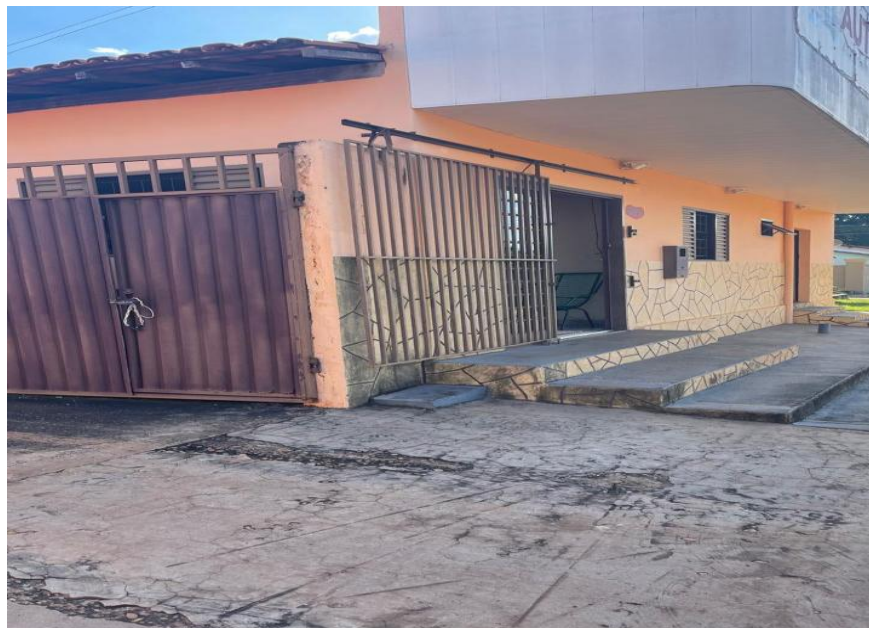
Figura 2 – visão da frente do imóvel avaliando.
