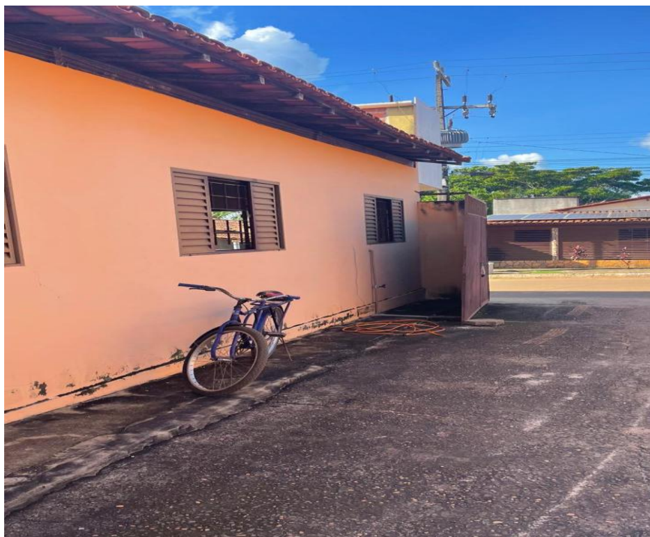
Figura 5 – visão da parte lateral da construção da loja.
