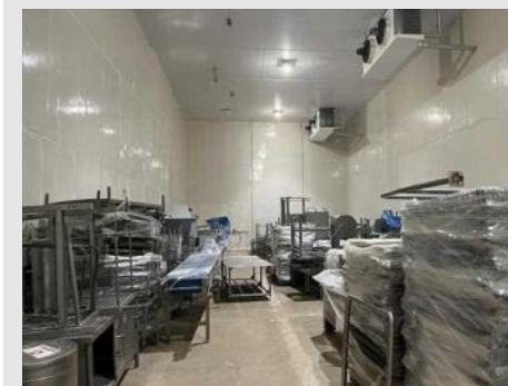
Produção Prédio BJ - Galpão
