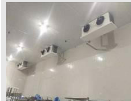
EVAPORADOR DE AR FORÇADO, C/ 2 VENTILADORES | Item: 79 |
