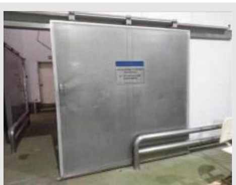
PORTA FRIGORÍFICA DE CORRER EM AÇO INOX MARCA TERMOPAINEL, DIM. 2.550X2.400X12 MM | Item: 11 |
