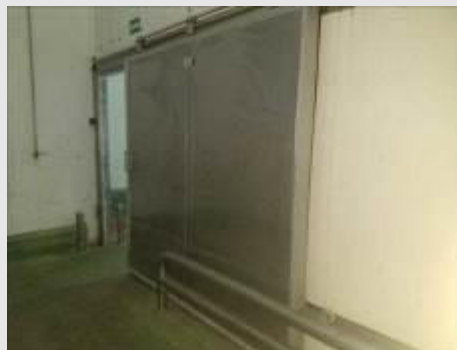
PORTA FRIGORÍFICA DE CORRER EM AÇO INOX MARCA TERMOPAINEL, DIM. 2.550X2.400X12 MM | Item: 6 |
