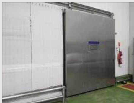
PORTA FRIGORÍFICA DE CORRER EM AÇO INOX, DIM. 2.600X3.000X10 MM | Item: 20 |
