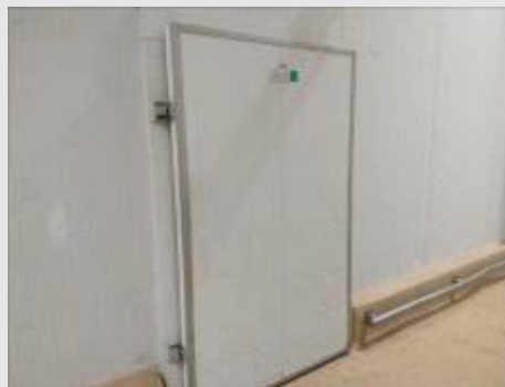
PORTA FRIGORÍFICA DE CORRER EM ISOPAINEL MARCA TERMOPAINEL, DIM. 1.300X2.150X10 MM | Item: 80 |
