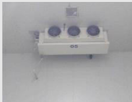
EVAPORADOR DE AR FORÇADO MARCA FROST FRIIO, C/ 3 VENTILADORES | Item: 41 |
