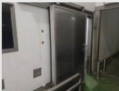
PORTA DE ISOLAMENTO TÉRMICO DE CORRER EM AÇO INOX, DIM. 1.350X2.350X12 MM | Item: 4 |
