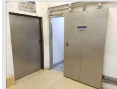
PORTA FRIGORÍFICA DE CORRER EM AÇO INOX MARCA MBP ISOBLOCK, DIM. 1.300X2.100X12 MM | Item: 82 |
