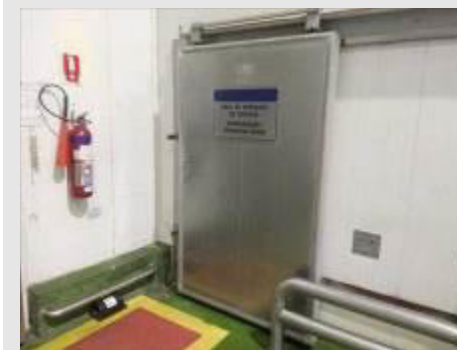
PORTA DE ISOLAMENTO DE CORRER EM AÇO INOX MARCA TERMOPAINEL, DIM. 1.350X2.000X12 MM | Item: 21 |
