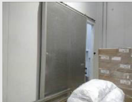
PORTA FRIGORÍFICA DE CORRER EM AÇO INOX MARCA MBP ISOBLOCK, DIM. 2.300X3.100X18 MM | Item: 74 |
