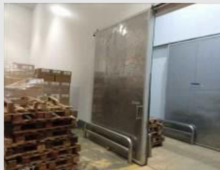
PORTA FRIGORÍFICA DE CORRER EM AÇO INOX MARCA MBP ISOBLOCK, DIM. 2.300X3.100X18 MM | Item: 68 |
