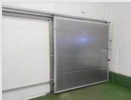
PORTA FRIGORÍFICA DE CORRER EM AÇO INOX MARCA MBP ISOBLOCK, DIM. 2.550X2.400X12 MM | Item: 19 |
