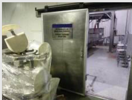
PORTA FRIGORÍFICA DE CORRER EM AÇO INOX, DIM. 1.350X2.100X12 MM | Item: 50 |
