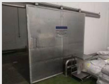
PORTA FRIGORÍFICA DE CORRER EM AÇO INOX, DIM. 2.750X2.400X12 MM | Item: 5 |
