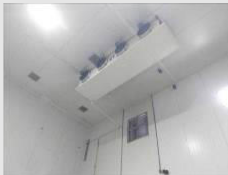
EVAPORADOR DE AR FORÇADO MARCA FROST FRIO, C/ 4 VENTILADORES | Item: 22 |
