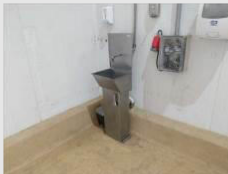
LAVATÓRIO EM AÇO INOX MARCA FRIGMANN HERMANN, 1 BICA, ACIONAMENTO C/ JOELHO | Item: 71 |
