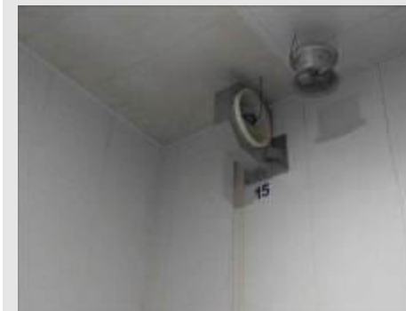
CIRCULADOR DE AR EM AÇO INOX, DIAM. 1.000 MM | Item: 24 |
