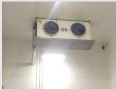
EVAPORADOR DE AR FORÇADO, C/ 2 VENTILADORES | Item: 81 |
