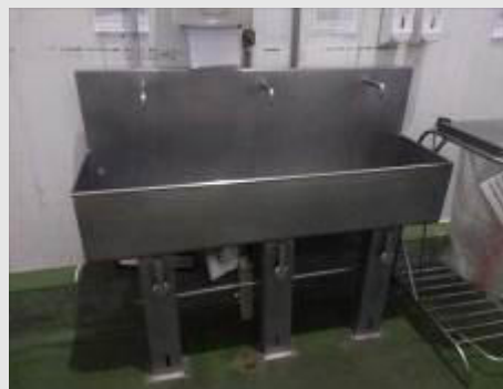
LAVATÓRIO EM AÇO INOX, 3 BICOS, ACIONAMENTO C/ JOELHO | Item: 2 |
