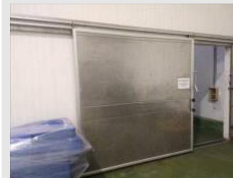
PORTA FRIGORÍFICA DE CORRER EM AÇO INOX, DIM. 2.550X2.0400X12 MM | Item: 42 |
