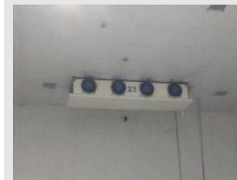
EVAPORADOR DE AR FORÇADO MARCA FROST FRIO, C/ 4 VENTILADORES | Item: 16 |
