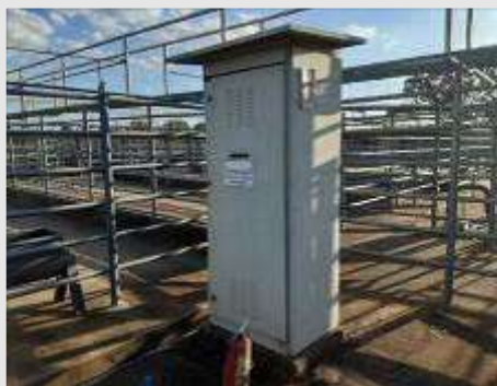
QUADRO DE LUZ E FORÇA DO CURRAL DIM.800X2000X650MM 380V | Item: 38 |
