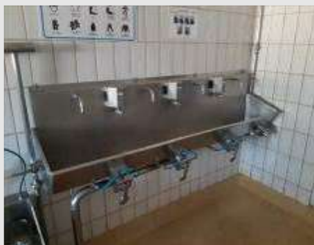
LAVATÓRIO EM AÇO INOX COM 4 BICOS ACIONAMENTO JOELHO | Item: 8 |
