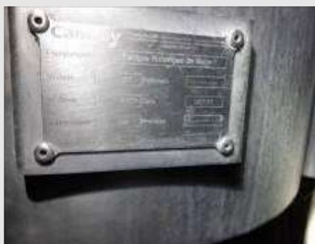
TANQUE CILÍNDRICO VERTICAL EM AÇO INOX PARA RETENÇÃO DE SEBO MARCA CAMREY MOD12.051 NR.7518-01.001 CAP.100LTS | Item: 33 |
