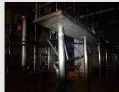
PLATAFORMA EM AÇO INOX PARA QUARTO ESQUERDO DIM.750X7000MM | Item: 6 |
