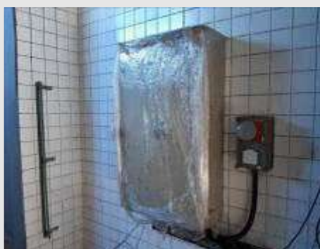
PAINEL ELÉTRICO PARA ABATE SANITÁRIO DIM.1000X600X250MM 380V | Item: 44 |
