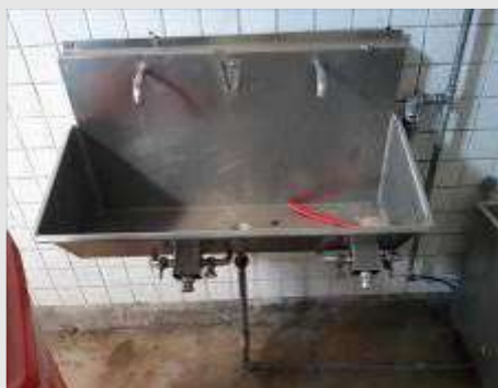
LAVATÓRIO EM AÇO INOX COM 2 TORNEIRAS ACIONAMENTO JOELHO | Item: 41 |
