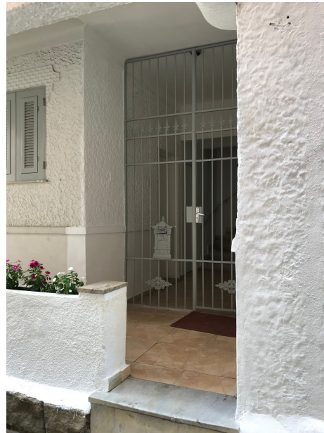
HALL DE ENTRADA TERRÉO
