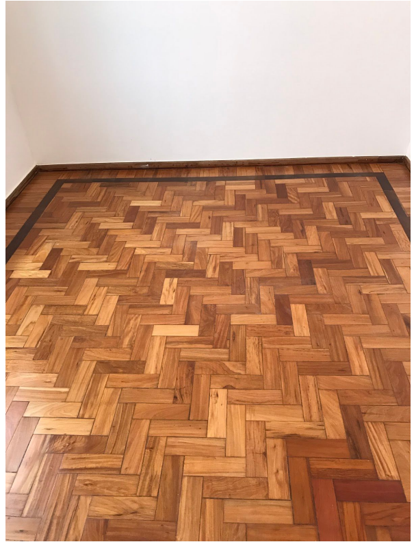
QUARTO 1 - DETALHE PISO
