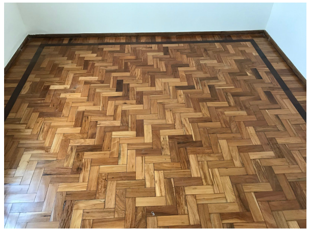
QUARTO 2 - DETALHE PISO
