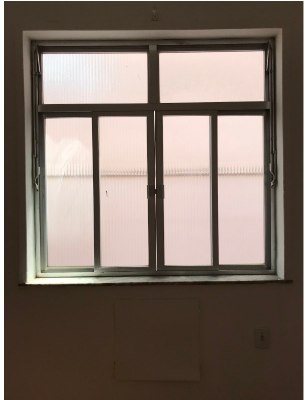
QUARTO 1 - DETALHE JANELA
