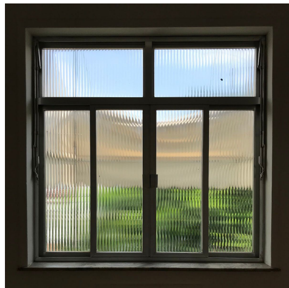
QUARTO 2 - DETALHE JANELA
