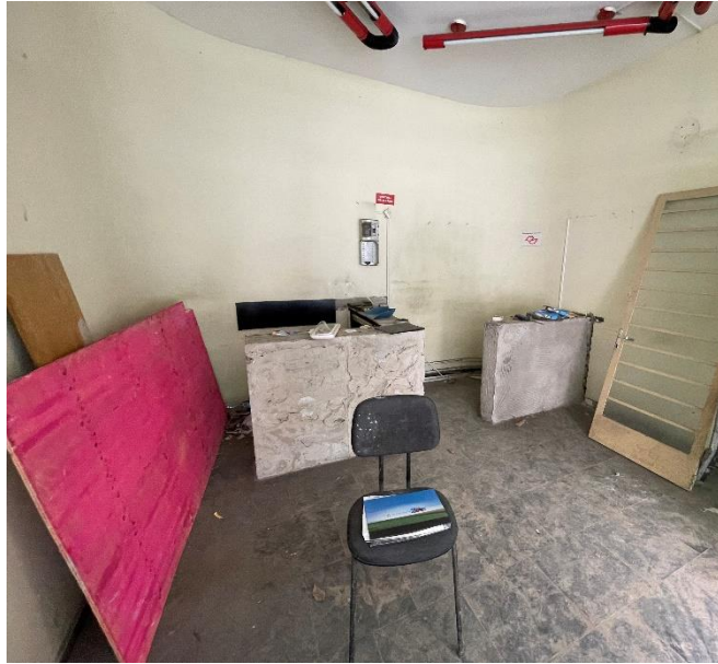
Vista entrada salão principal - Térreo
