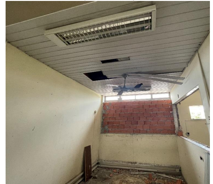
Sala – fechamento de vão com alvenaria – 2º pav.
