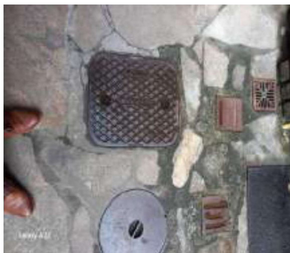
Rede de água e esgoto
