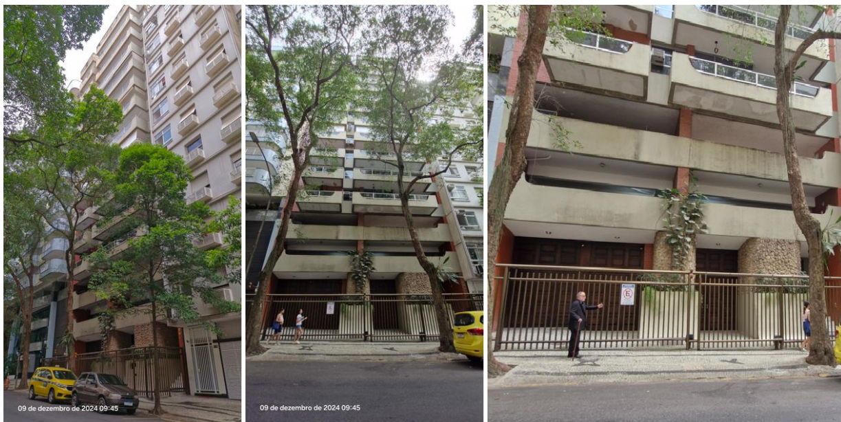
Foto 4 – Vista das fachadas da edificação
