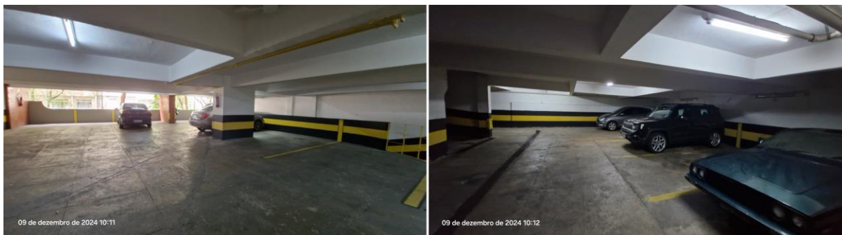
Foto 25 – Pavimentos garagem – Condomínio
