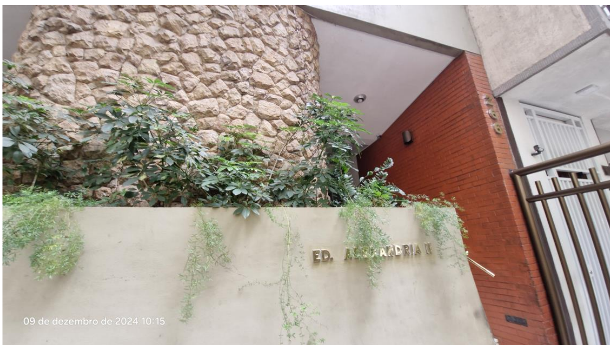
Foto 5 – Do Acesso para a edificação
