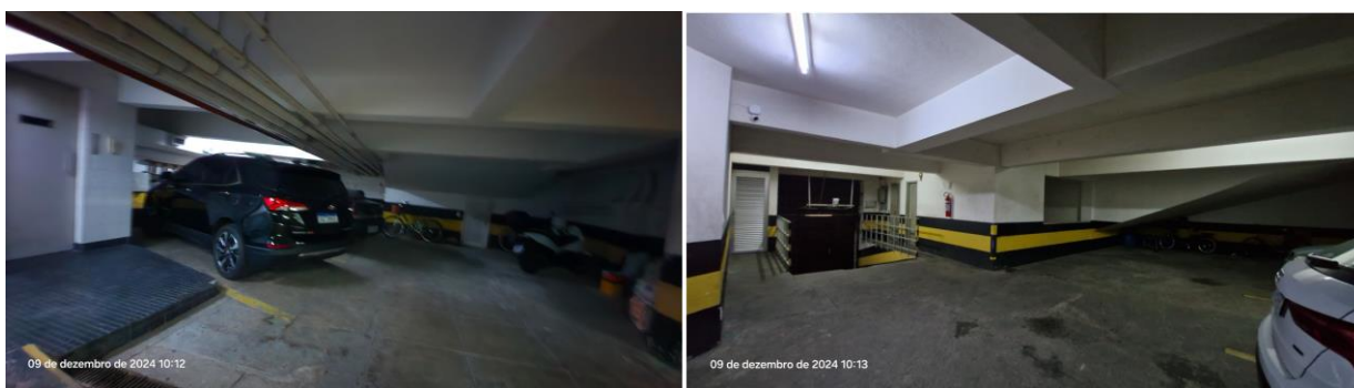
Foto 26 – Pavimentos garagem – Condomínio
