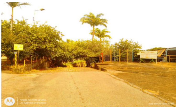
Foto 10: Acesso ao 3º galpão
