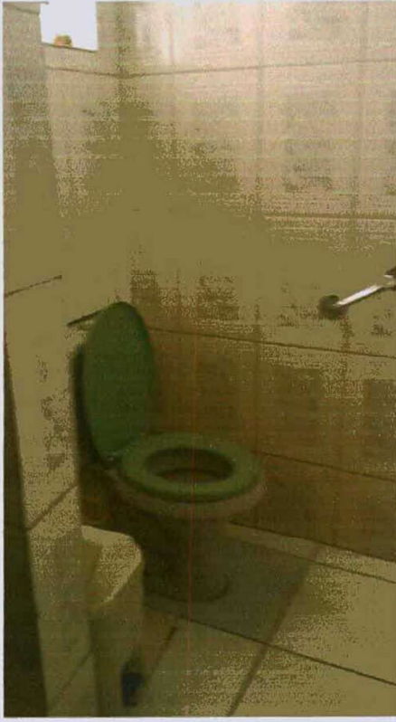
FOTO 04: Banheiro com modificações e adaptação para idoso.
