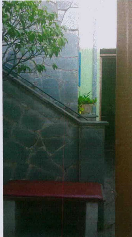
FOTO 06: Vista da escada de acesso a residência.
