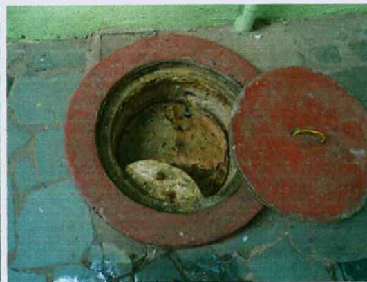
FOTO 39: Instalação de caixa de gordura no Bar.
