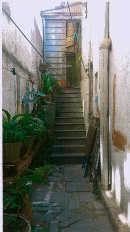
FOTO 15: Tubulação de água trocada.
