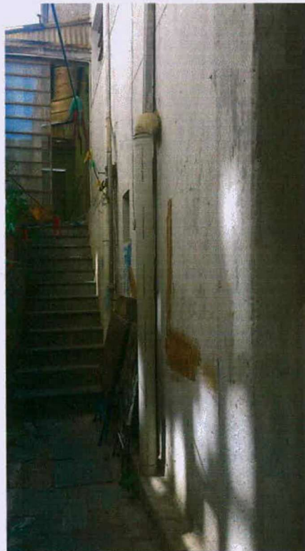
FOTO 16: Tubulação de água trocada.
