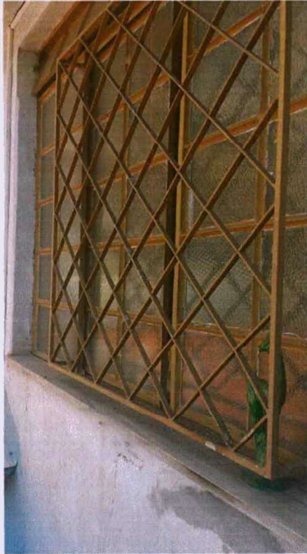
FOTO 14: Grades nas janelas.
