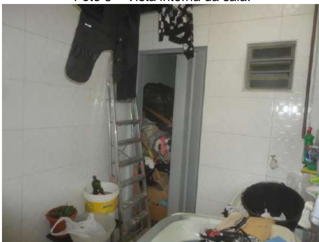
Foto 5 – Vista interna área de serviço.
