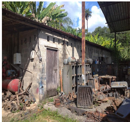
8) Oficina aos fundos da área coberta 01
