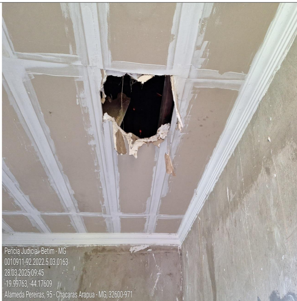
FOTO 38 Teto primeiro pavimento
