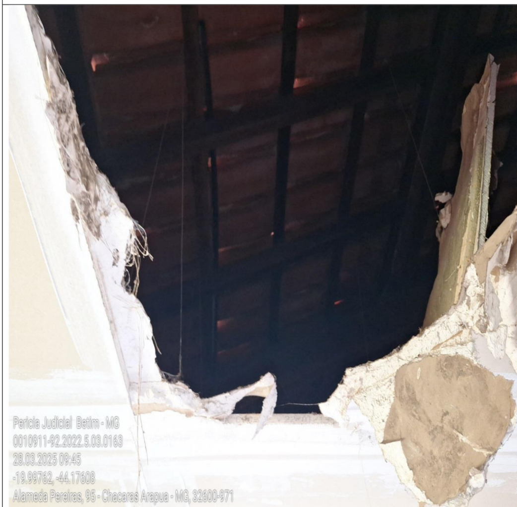
FOTO 39 Teto primeiro pavimento
