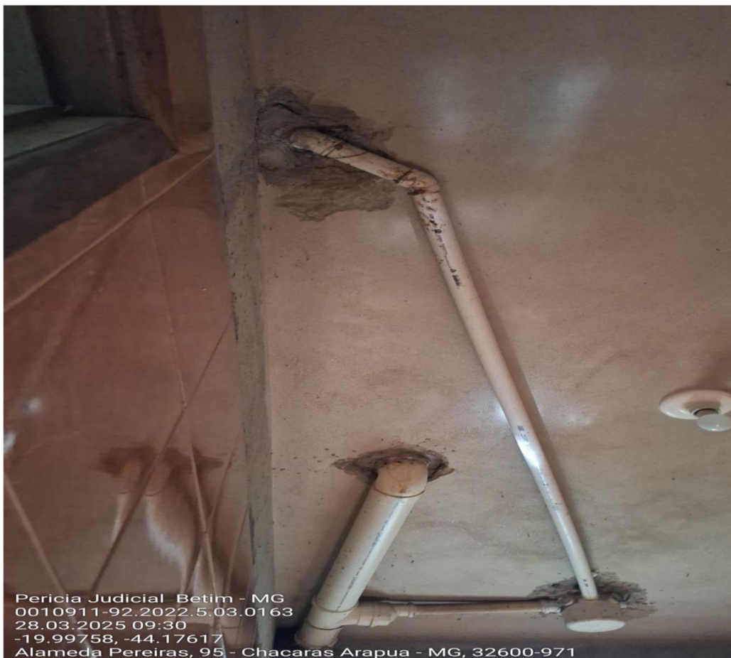
FOTO 18 – Banheiro Suíte – Pavimento térreo
