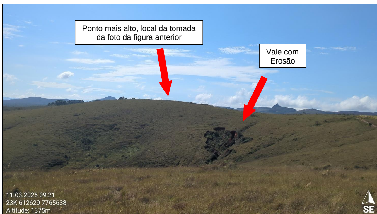
Figura 14:. Foto tomada de imóvel lindeiro para o vale com erosão que existe na área avaliada.
