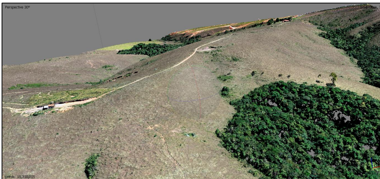
Figura 23: Vista 3D do terreno gerada pelo aerolevantamento, zoom na área com erosão no vale na face do Córrego Padre Domingos
