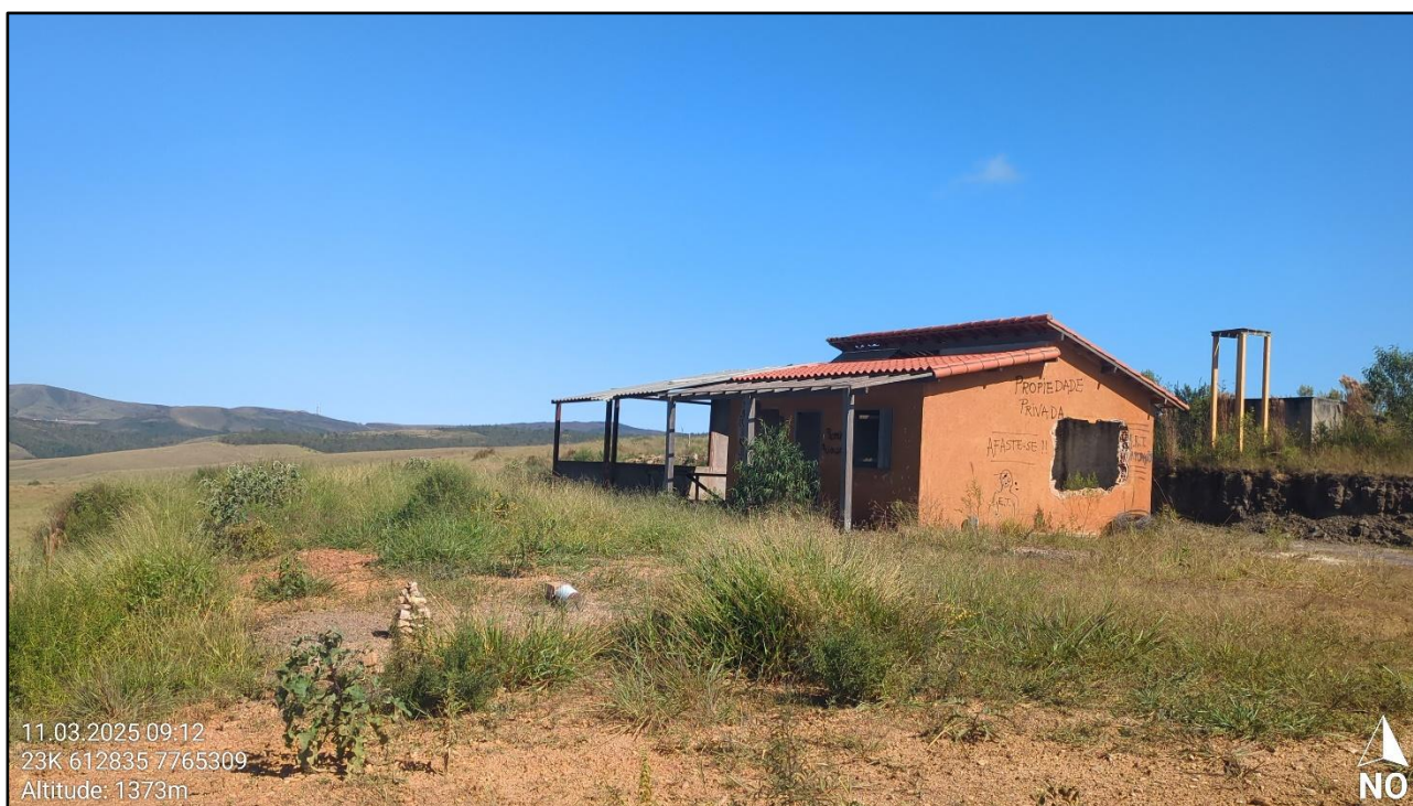
Figura 18: Edificação existente após a divisa/porteira (ver figura 8) da área avaliada.
